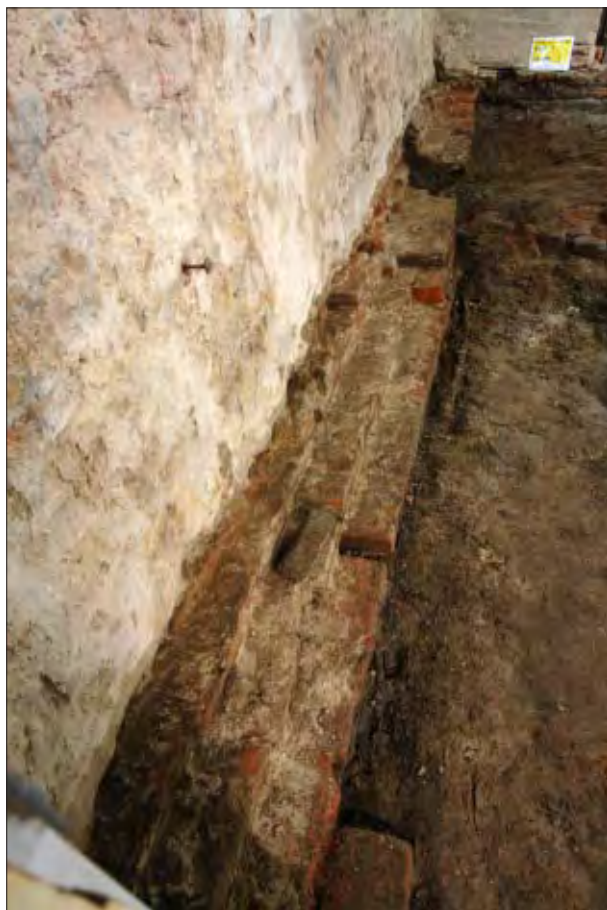
Afb. 4.9 De fundering van de noordelijke muur.
