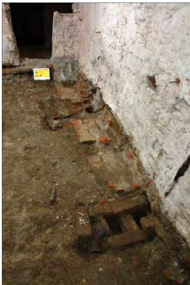
Afb. 4.3 De fundering van de zuidelijke muur en de afvoerbuis met ijzeren grape (achtergrond) en gemetselde put (voorgond).
