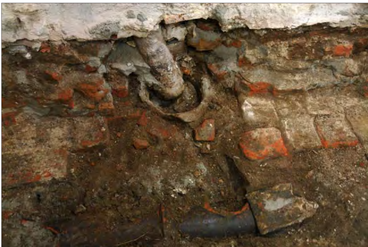
Afb. 4.4 De afvoerbuis met T-stuk, de ingegraven ijzeren grape en de afvoerbuis in de muur.
