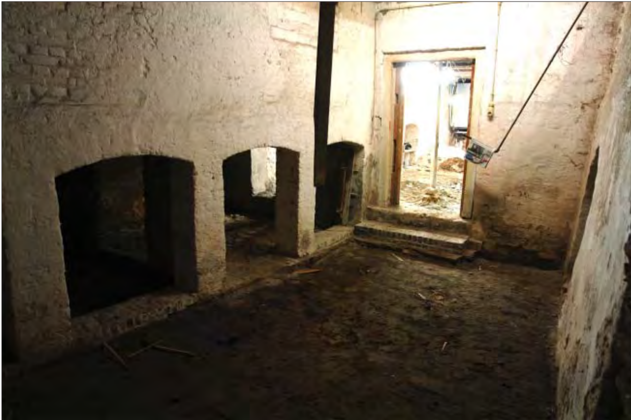
Afb. 2.4 Het voorste deel van de kelder in november 2013, gezien in westelijke richting.
