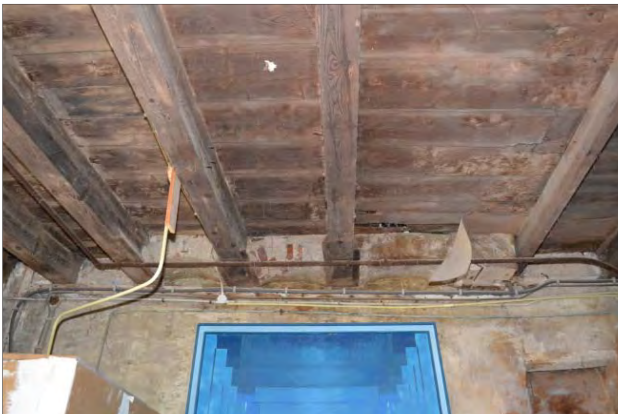
Afb. 2.3 Deeloverzicht van de balklaag in de achterkelder. Er is sprake van een enkelvoudige balklaag, vermoedelijk uit de negentiende eeuw. Bij de linkerzijgevel zijn smalle troggewelfjes herkenbaar, die de stookvloer van een schouw op de begane grond vormen. Rechts van deze troggewelfjes is een dikkere (moer)balk zichtbaar, die vlak naast deze troggewelfjes is afgezaagd. In plaats daarvan is een veel ielere balk herplaatst.
