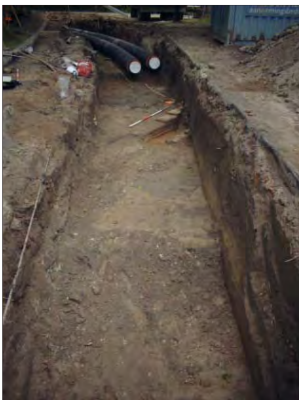
Afb. 3.34 De restanten van de noordelijke ruimte (M18 en M19), vanuit het oosten gezien.
