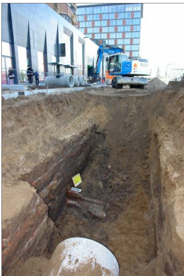
Afb. 4.4 Goot S2, gezien in westelijke richting. Op de voorgrond een deel van het nieuw aangelegde IT-riool.
