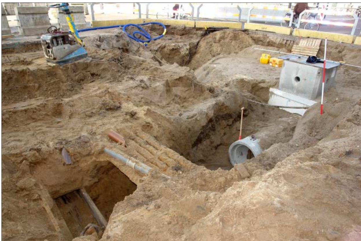
Afb. 3.3 Het graven van de sleuf voor het IT-riool werd bemoeilijkt door de grote hoeveelheid kabels en leidingen, gezien in noordoostelijke richting.
