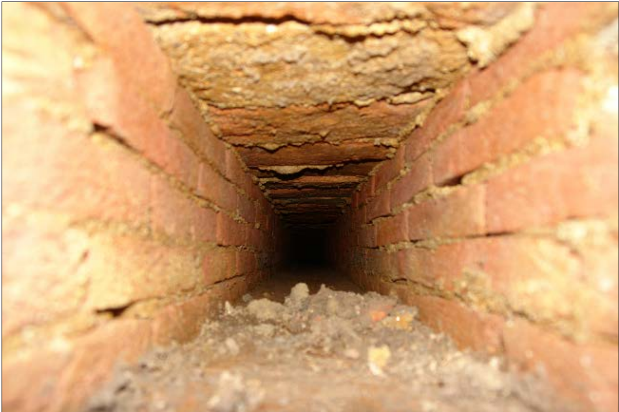
Afb. 4.6 De binnenkant van goot S2, gezien in zuidelijke richting.
