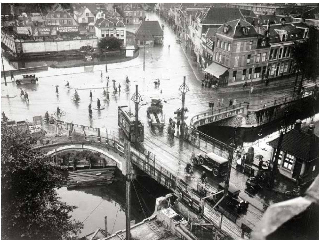
Afb. 5.2 Foto uit 1927 met gezicht op de Catharijnebrug over de Stadsbuitengracht tijdens de werkzaamheden ter verbreding van de brug. De doorgang onder de Smakkelaarsbrug uit 1881 is opgevuld met grond en er is een nieuwe onderdoorgang aangelegd, die ditmaal schuin onder het kruispunt door loopt en ten noorden van de Catharijnebrug uitmondt op de Stadsbuitengracht (Het Utrechts Archief, catalogusnummer 40653).
