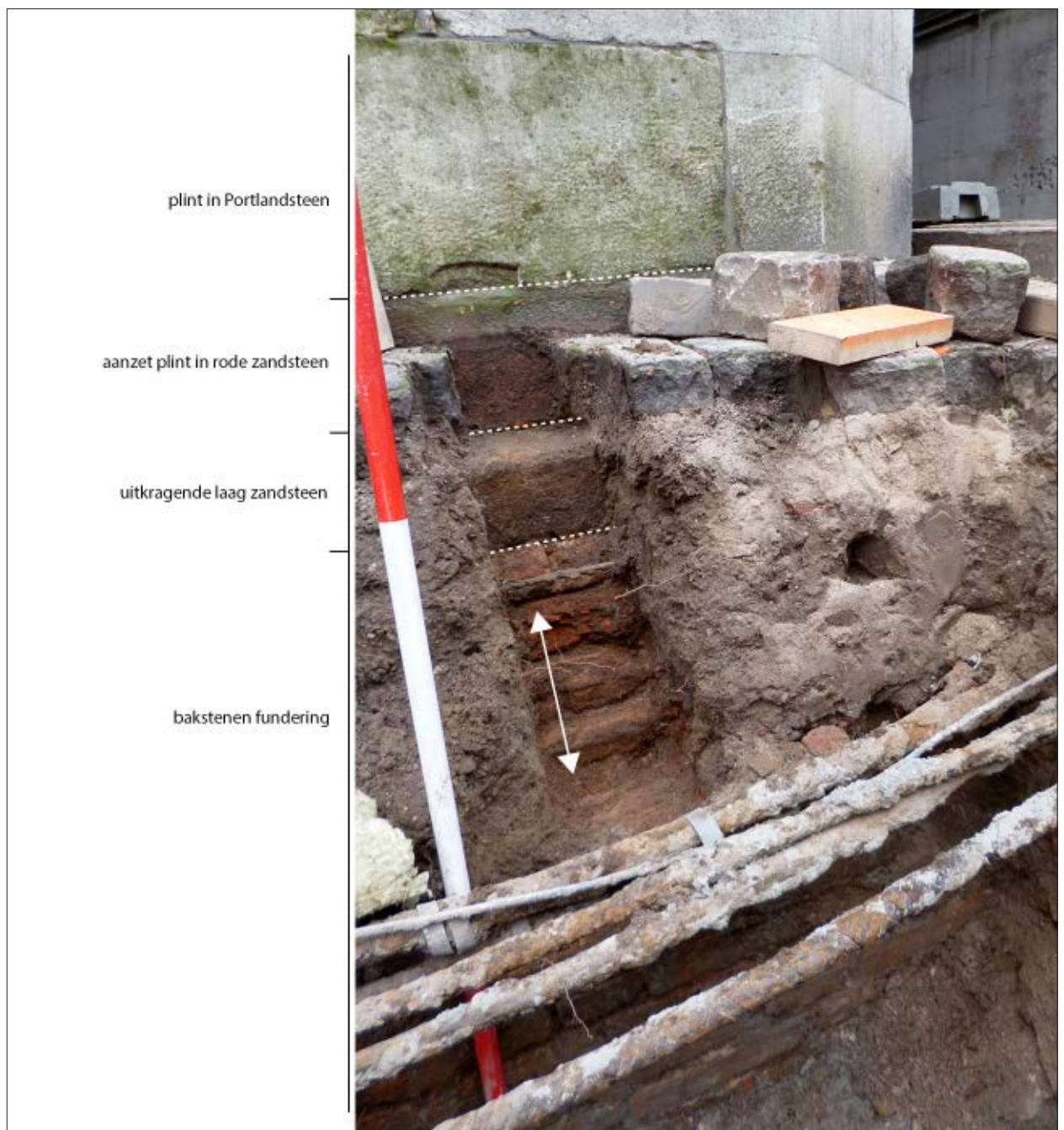
Afb. 4.17 De uitkragende natuurstenen laag die boven op de bakstenen fundering geplaatst is. Gezien richting het westen. (Foto gemaakt in 2013 door F. Kipp.)
