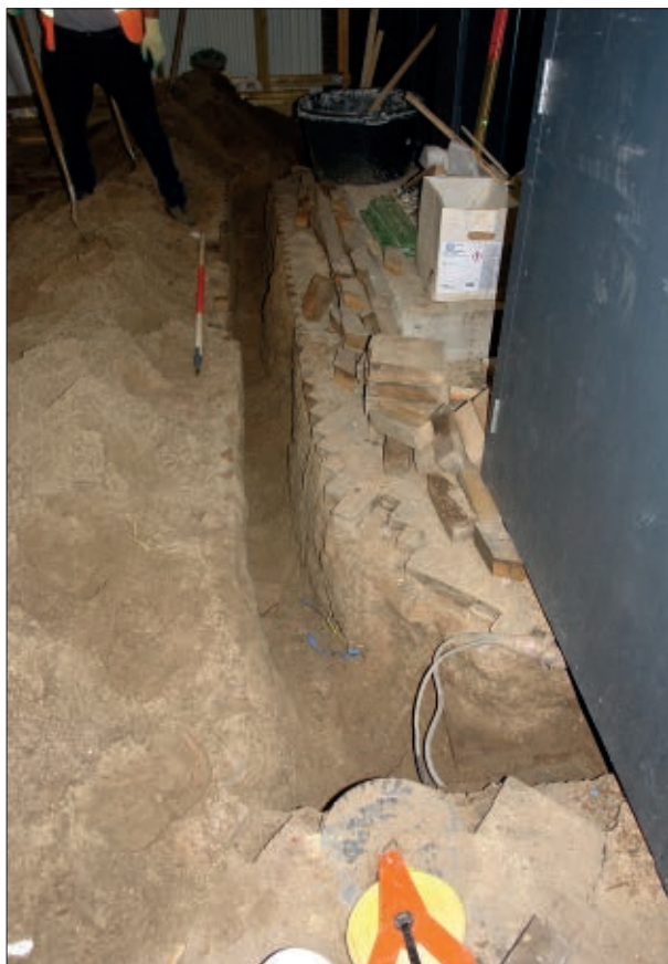
Afb. 6.4 Overzicht van de sleuf, richting het zuiden.
