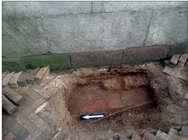
Afb. 4.5 Put 6 met de aanzet van de bakstenen fundering van de Domtoren.
