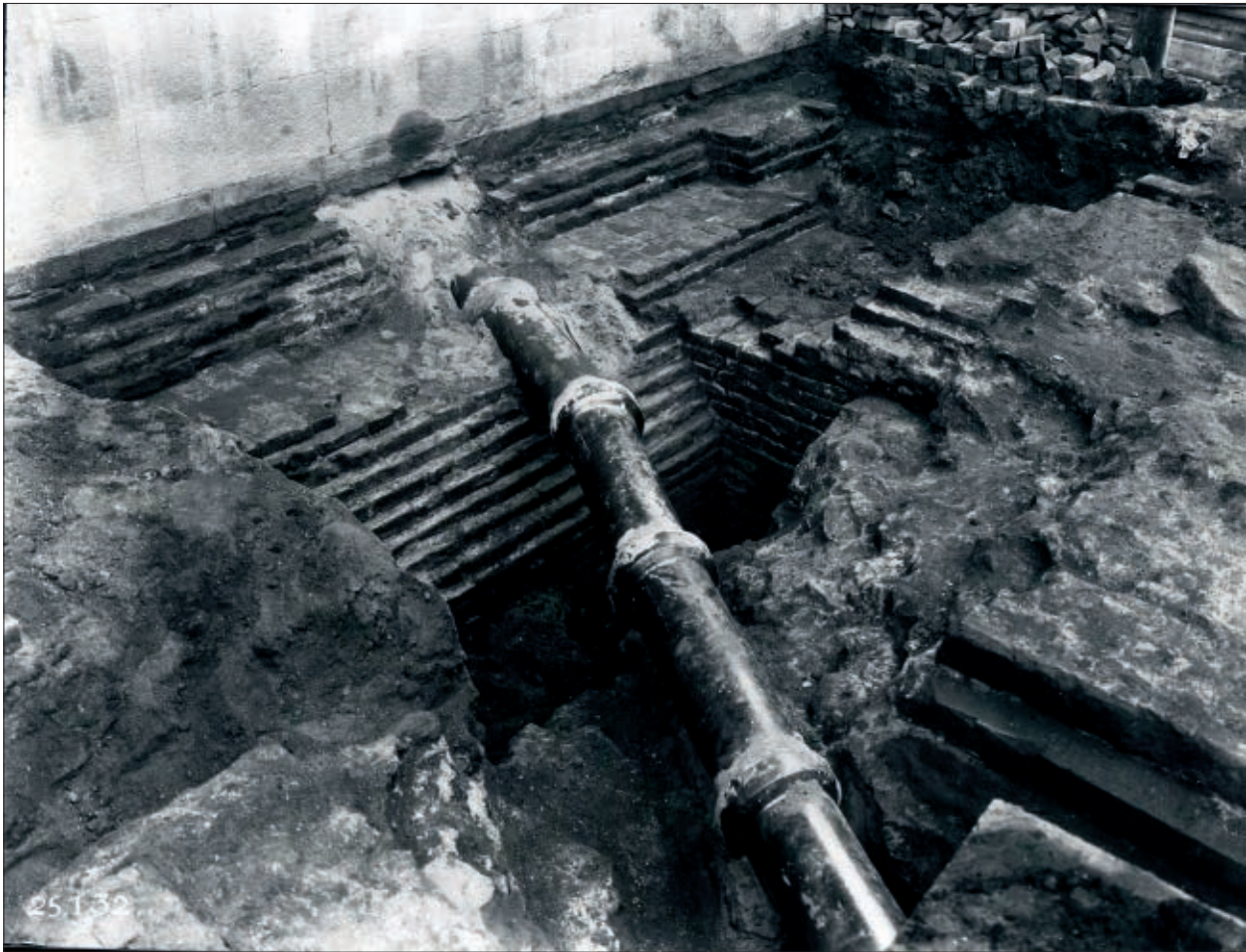
Afb. 4.18 Foto uit 1932 van de noordzijde van de Domtoren fundering. Opvallend is het gebruik van baksteen direct onder de plint.
