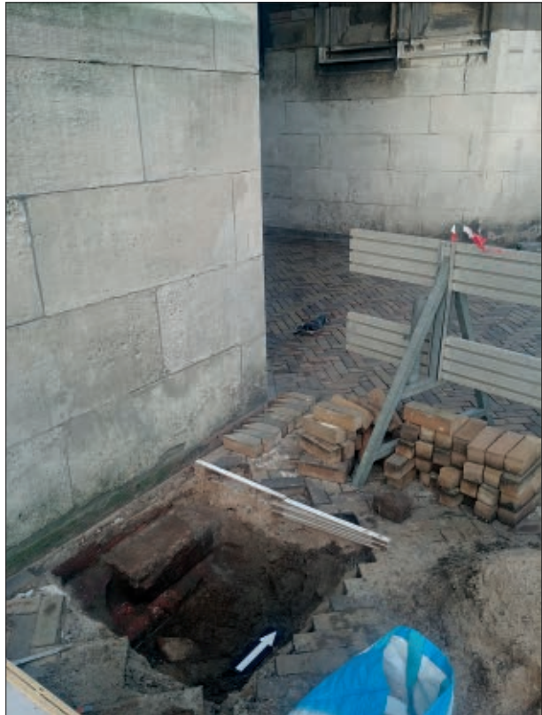
Afb. 4.12 Put 9 met ook daarin een zandstenen funderingslaag met daaronder een bakstenen laag.
