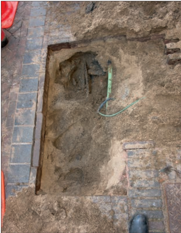
Afb. 5.2 Het kijkgat in de Servetstraat (foto richting het westen).
