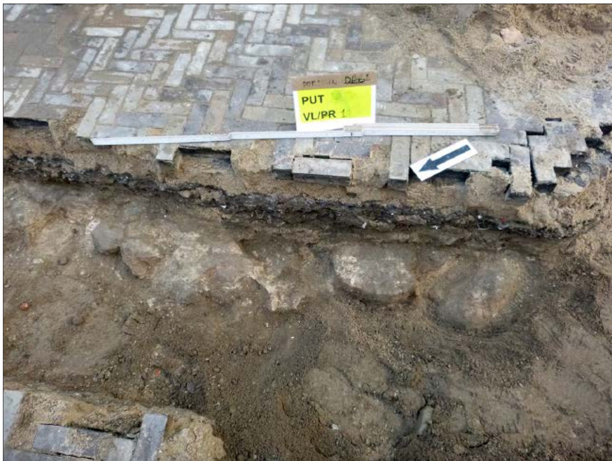
Afb. 3.2 De natuurstenen fundering van de Maartenstoren zoals zichtbaar in put 3. Opvallend zijn de ronde natuurstenen blokken en het overmatig gebruik van mortel.
