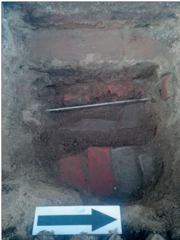
Afb. 4.8 De initiële put 8 met de twintigste-eeuwse baksteenrij op de voorgrond, de aanzet van de zandstenen sarcofaag daar achter en op de achtergrond de bakstenen en zandstenen fundering van de Domtoren.
