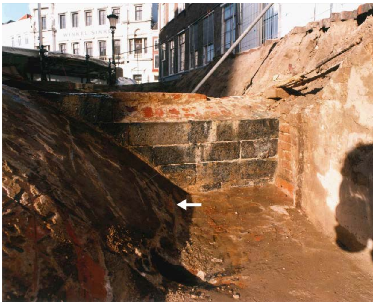
Afb. 5.3 De waarneming van de Doornikse kalksteen in de wand van de brugleuning in 2002, gezien vanuit het zuiden. Met de witte pijl is de aanzet van de veertiende-eeuwse verbreding aangegeven.
