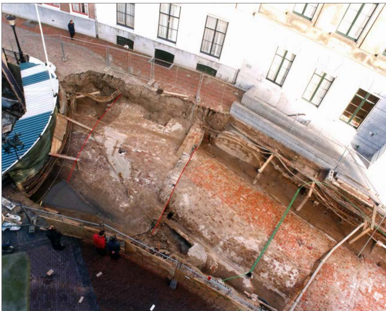
Afb. 5.2 Gezicht op de openliggende Stadhuisbrug in 2002, gezien vanuit het zuidwesten. De Broodbrug is met rode lijnen aangegeven.
