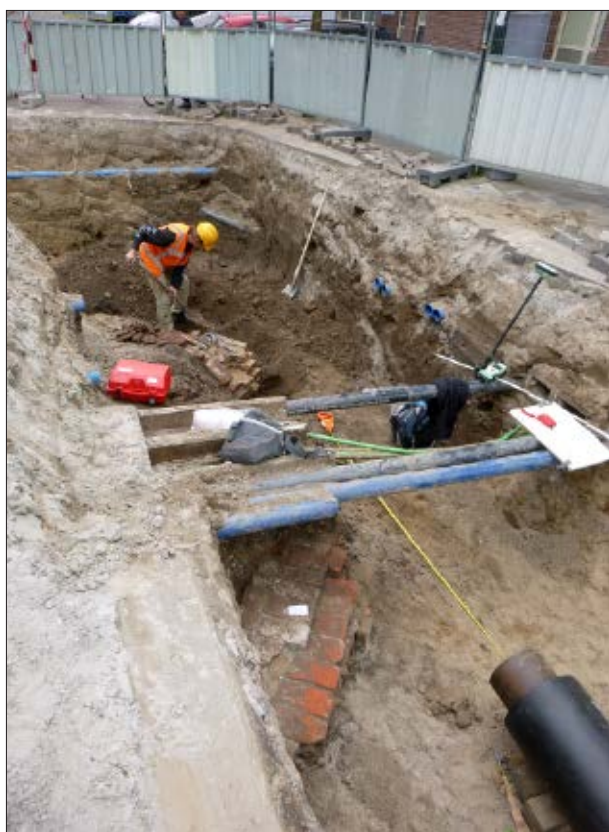
Afb. 5.2 De vijftiende-eeuwse fundering (voorground) en het veertiende-eeuwse kelderrestant (achtergrond) van PAV01, gezien in oostelijke richting.
