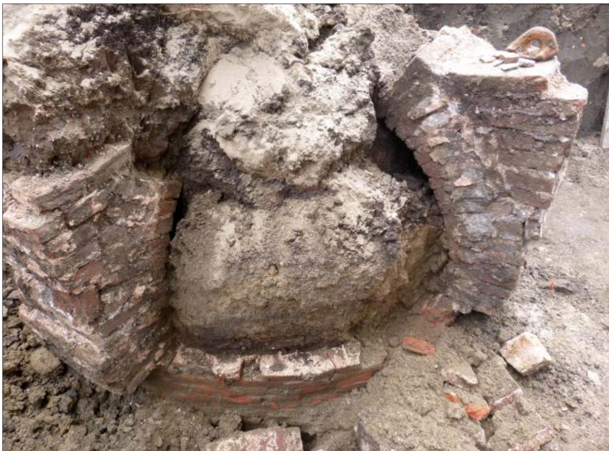
Afb. 4.5 Water- of beerput S1 van PAV01 na het verwijderen van een kwart van de koepel, gezien in zuidelijke richting. Duidelijk zichtbaar zijn de twee ribben en de driehoekige blokken die hierbovenop zijn gemetseld.
