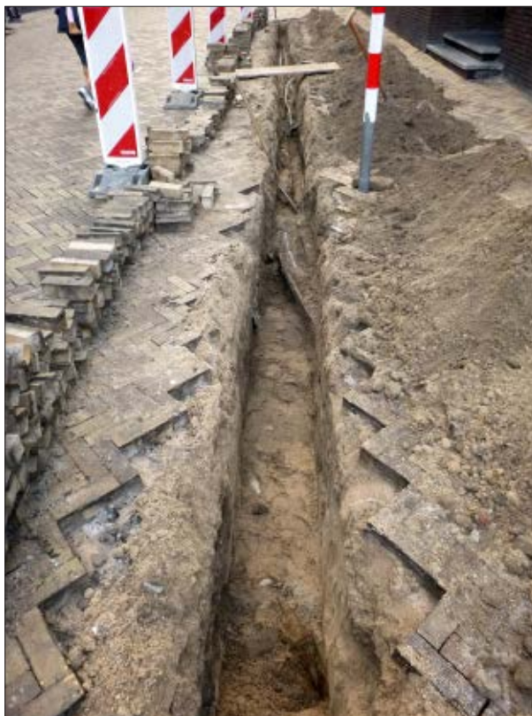
Afb. 4.2 Het eerste gedeelte van de sleuf ter hoogte van het Domplein. Duidelijk te zien zijn de kabels en leidingen en het scherpe zand waaruit de sleuf bestaat. Gezien vanuit het oosten.
