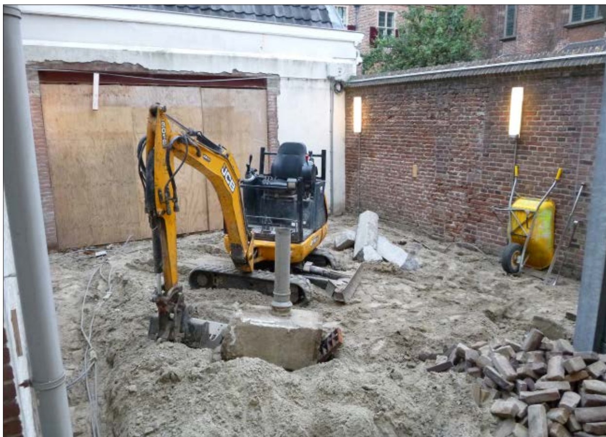
Afb. 3.1 Een overzicht van het onderzoeksgebied tijdens het verwijderen van de bestrating en het afgraven van het recente ophogingszand, gezien richting het zuiden.
