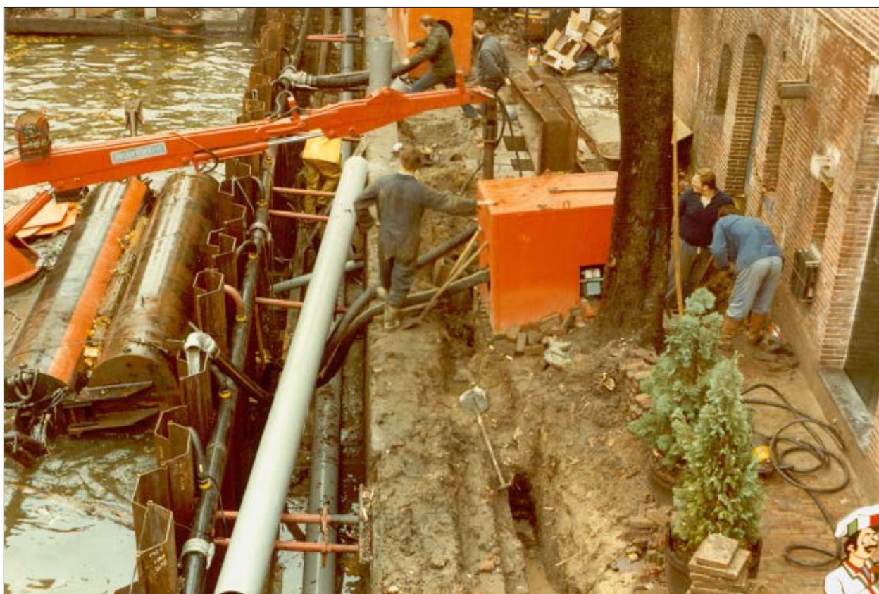
Afb. 1.3. Aanleg van het riool in de gracht ergens in de jaren 80. De man in de groene overall staat op de walmuur. Links van de walmuur wordt het riool (plastic buizen) in de leeggepompte ruimte tussen de walmuur en een stalen damwand gelegd.
