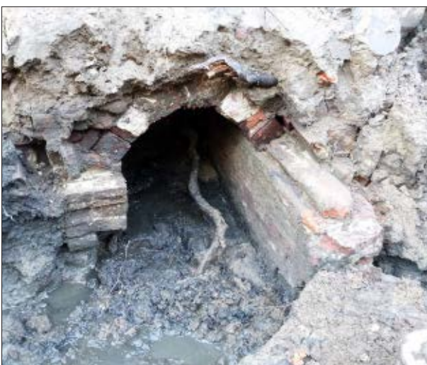
Afb. 4.10 Het riool S11 gefotografeerd naar het westen. Een boomwortel steekt uit het riool.
