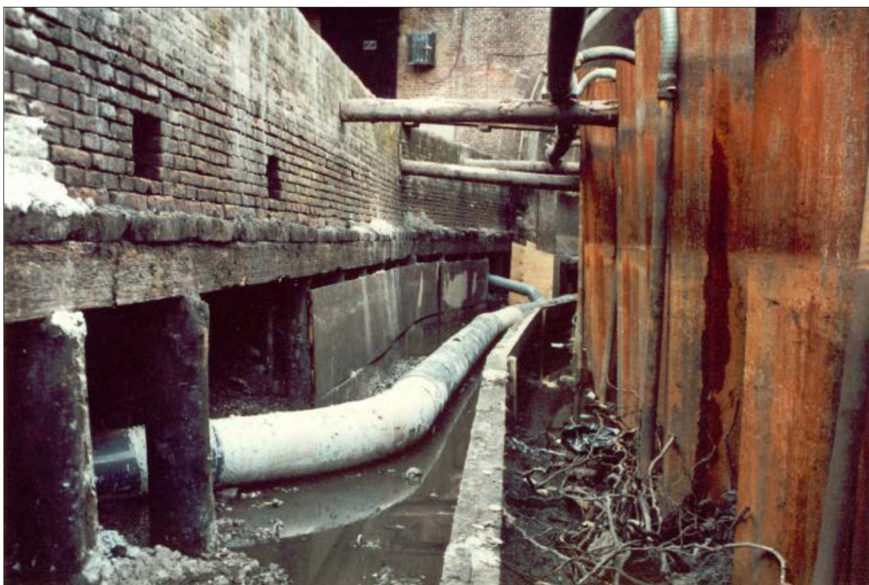
Afb. 1.4 Aanleg van riool in de jaren 80. Het nieuwe riool is in de droog gepompte ruimte tussen de walmuur (links) en de stalen damwand (rechts) gelegd. Onder de walmuur zijn de groene funderingspalen te zien die blootgesteld zijn aan zuurstof in de lucht.
