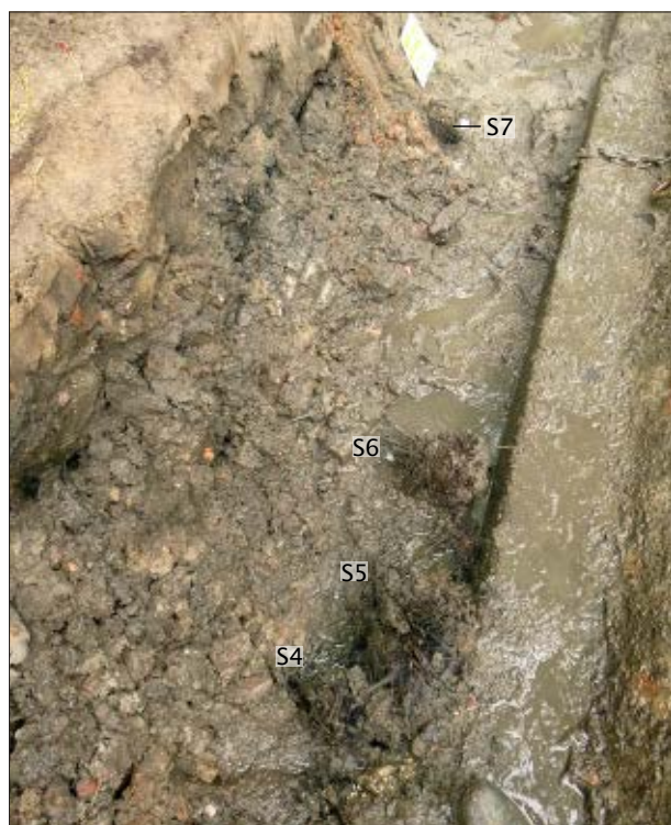
Afb. 4.27 De houten palen S4, S5, S6 en S7 in vlak 1 gefotografeerd naar het zuiden. De betonnen rand rechts hoort bij de voetplaat van de te restaureren walmuur.
