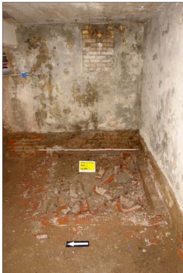
Afb. 4.13 De gemetselde bak S14 recht onder de dichtgezette koekoek. Net boven de meetlat lijkt zich een gewelf af te tekenen als een vage verkleuring die tot de onderkant van de pleisterlaag op de muur reikt. De foto is genomen naar het oosten.
