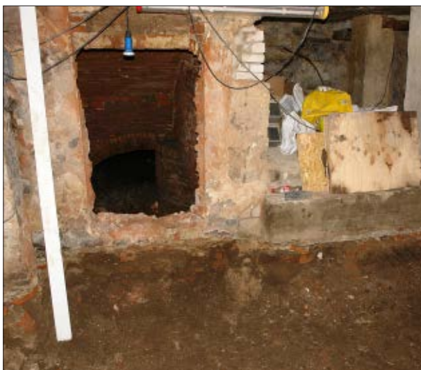
Afb. 4.8 De net uitgehakte deuopening die vanuit werkput 3 toegang gaf tot de verborgen ruimte erachter (werkput 4). Binnenin die ruimte is de boogconstructie van de inlaat naar de grote slokop onder de Mariaplaats te zien. De foto is genomen naar het westen.
