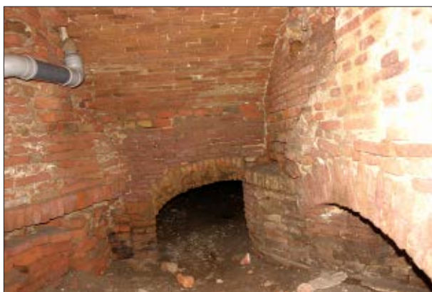
Afb. 4.9 Werkput 4 van binnen. Aan de rechterkant is de monding van de noord-zuid lopende kleine slokop te zien (S10/S11). Recht vooruit zit de opening die leidt naar de grote slokop onder de Mariaplaats. Helemaal links lijkt een opening te zijn dichtgezet onder de horizontale rollaag. De foto is genomen naar het westen.
