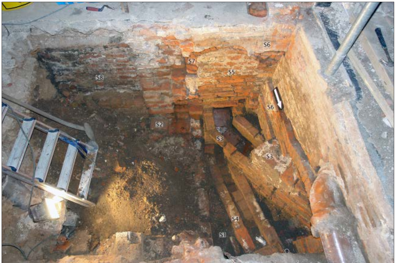
Afb. 4.3 Overzicht van de westkant van werkput 1 (liftschacht) nadat 1,2 meter was uitgegraven en de goten en het muurwerk waren schoongemaakt. De foto is genomen naar het zuiden.
