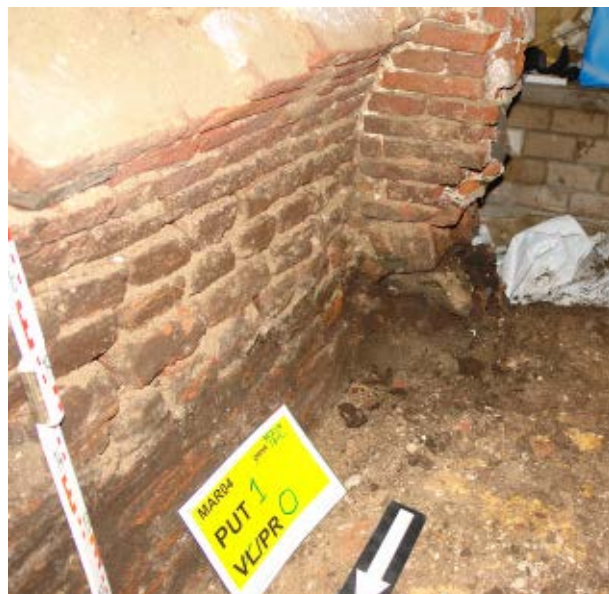
Afb. 4.7 Het gemetselde riool (slokop) in het oost- en zuidprofiel van werkput 1 (zie afb. 4.2, zuidprofiel). Links is de oorspronkelijke oostwand van de slokop te zien (S11) met daarop de aanzet van het jongere gewelf van kleinere stenen (S10). Aan de zuidkant van de werkput is naast de pas doorbroken muur nog de gedeeltelijke dichtzetting van de slokop te zien met daaronder een boogstukje van de nieuwe doorlaat. Onder het nieuwe boogstukje zit de donkerbruine laag beer S12.
