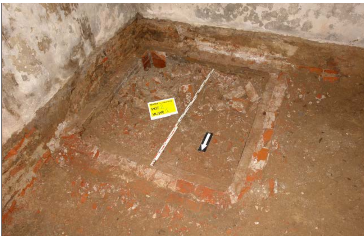
Afb. 4.14 De gemetselde bak S14. De foto is genomen naar het zuidoosten.
