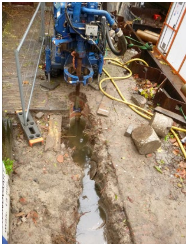
Afb. 3.5 Damwandmethode fase 3: rechts wordt de nieuwe damwand naast het oude onderloopshedscherm naar beneden gedrukt. Links staat nog een deel van de oude walmuur (rak 11 west).
