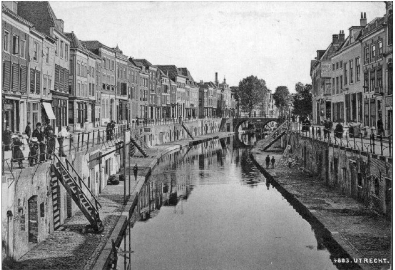
Afb. 4.7 Foto genomen rond 1900 vanaf de Zandbrug naar het zuiden. Op de werf aan de rechterkant (westzijde) is de voorganger te zien van de trap die nu ook op ongeveer dezelfde plek staat. Bron: Het Utrechts Archief cat. 66284.
