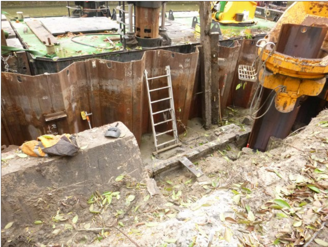
Afb. 3.5 Damwandmethode fase 3: rechts wordt de nieuwe damwand naast het oude onderloopshedscherm naar beneden gedrukt. Links staat nog een deel van de oude walmuur (rak 11 west).
