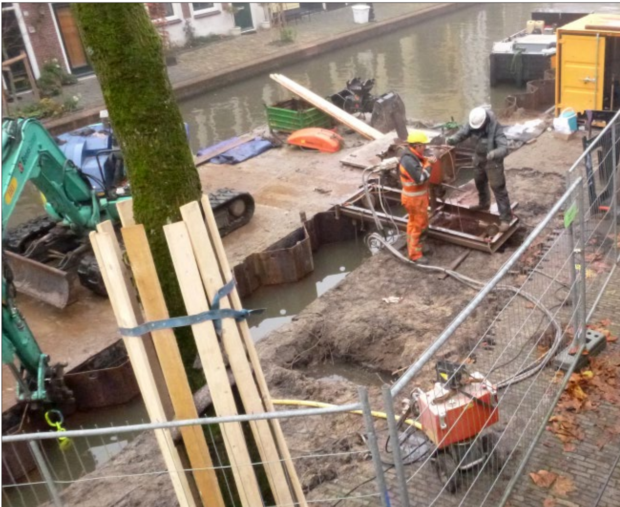
Afb. 3.2 Damwandmethode voorbereiding: via kleine gaten achter de walmuur wordt de muur in stukken gezaagd. Tussen de stalen damwand en de walmuur staat het water nog op het niveau van de gracht (rak 15 west).
