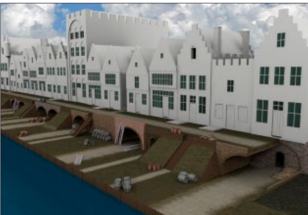
Afb. 2.1c Tunnels en werfkelders (1200-1300). De bouw van het tunneltje zal weliswaar snel navolging hebben gekregen, maar het duurde niet lang of er werden perceelbrede werfkelders met tongewelf gebouwd. Zo konden de werfkelders zelf ook voor opslagruimte worden gebruikt. Om die reden werden op den duur vrijwel alle tunneltjes door werfkelders vervangen.
