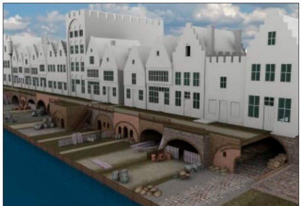
Afb. 2.1d Aan beide zijden vol met werfkelders (1300-1500). Na 1300 kwam de bouw van de werfkelders aan de Oudegracht goed op gang. Nieuwe tunneltjes werden er niet meer gemaakt en de werfkelders vormden steeds meer een aaneengesloten rij. De werfkelders werden ook steeds vaker afgesloten met een hek of met een bakstenen front.
