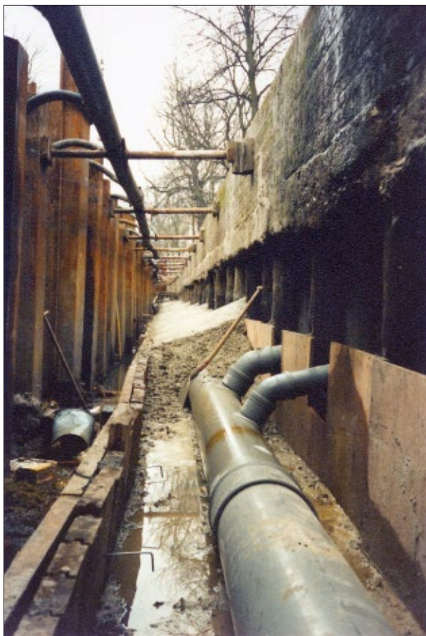
Afb. 1.5 Aanleg van het riool in de jaren 80. De huisaansluitingen zijn aan het nieuwe riool bevestigd en het geheel wordt afgedekt met zand en beton. Onder de walmuur (rechts) zijn de grenen funderingspalen onder de walmuur te zien.
