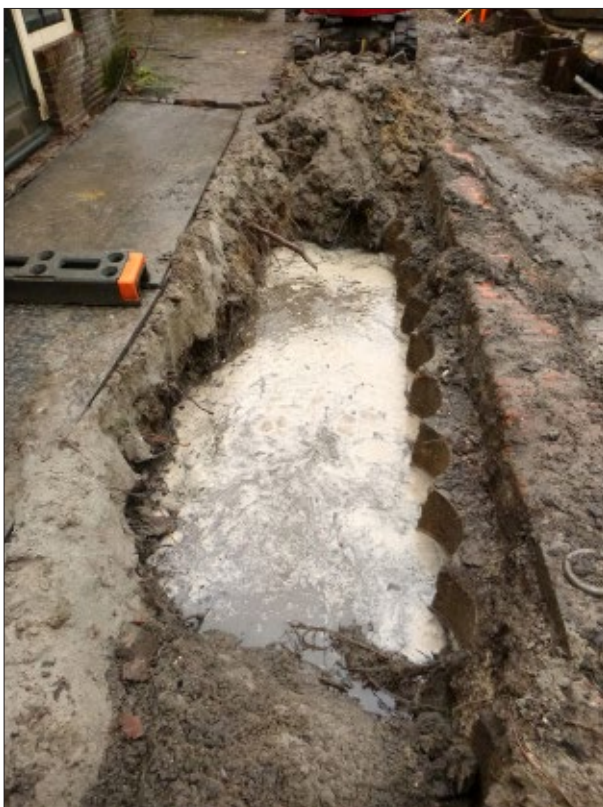
Afb. 4.13 Het wat ruimer uitgegraven gat ter hoogte van perceel 181. Geheel rechts het deel van de walmuur van baksteen dat normaal aan de werfkant zichtbaar is. Direct links daarvan het normaal ondergrondse gelegen deel van beton. Hierin zijn de boringen te zien waar de buispalen in geplaatst moeten worden.
