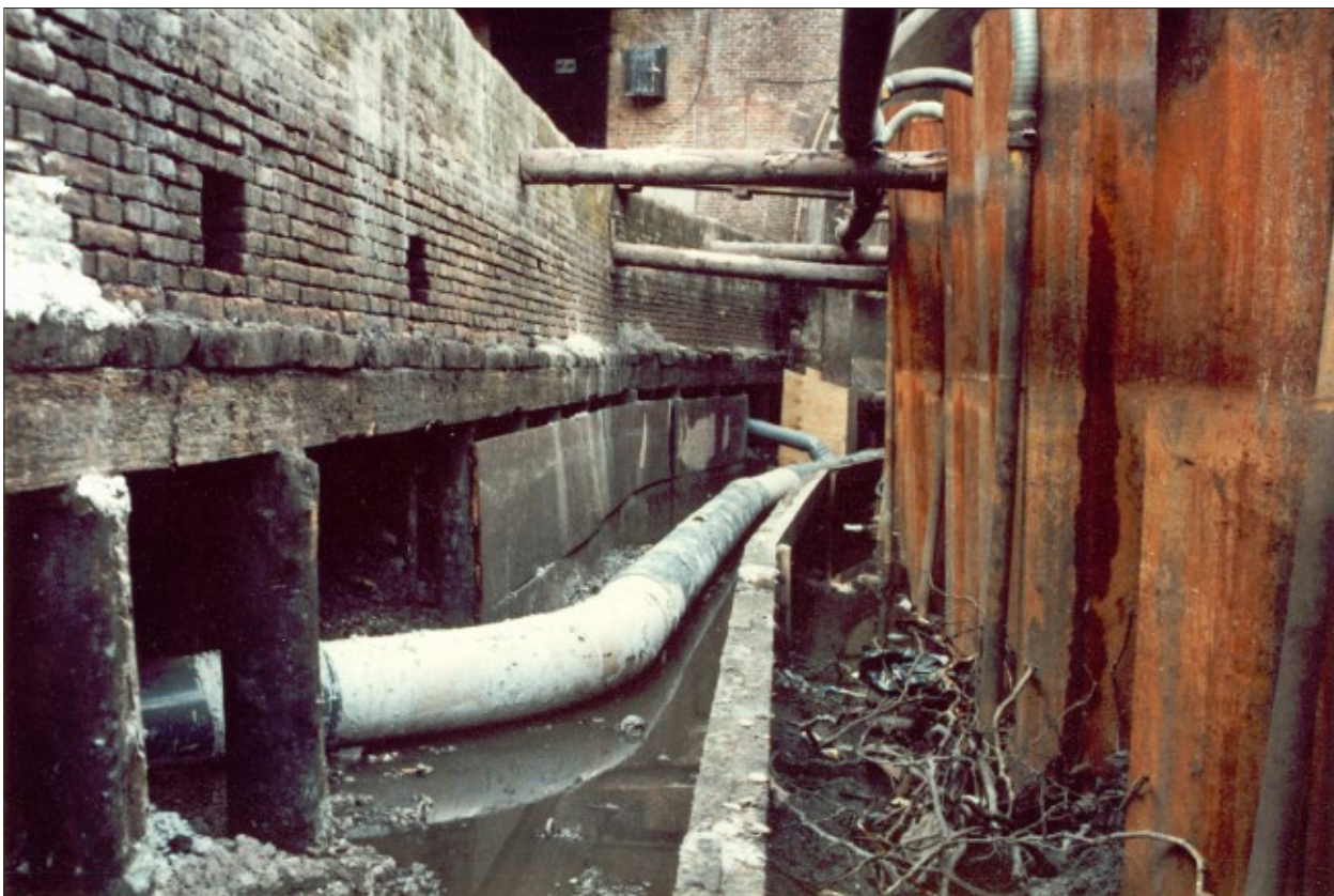
Afb. 1.4 Aanleg van riool in de jaren 80. Het nieuwe riool is in de droog gepompte ruimte tussen de walmuur (links) en de stalen damwand (rechts) gelegd. Onder de walmuur zijn de grenen funderingspalen te zien die blootgesteld zijn aan zuurstof in de lucht.
