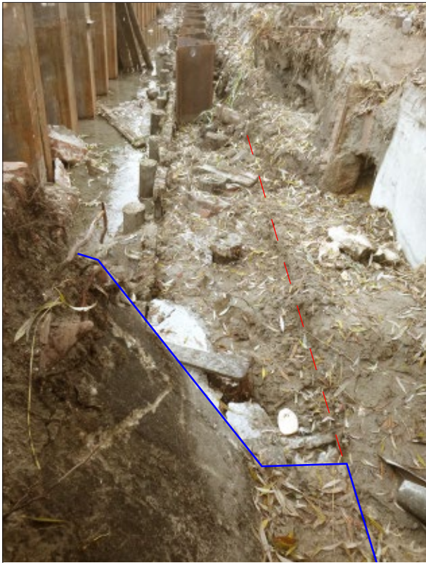
Afb. 4.17 Rak 11 west ter hoogte van perceel 215 gezien naar het zuiden. Op de voorgrond is met blauwe lijnen het ondergrondse betonnen deel van de nog resterende walmuur omlind die grotendeels uit beton bestond. Links van de blauwe lijn zijn de bakstenen te zien van de walmuurrand die zichtbaar was aan het werfoppervlak en langs de waterkant. Met de rode onderbroken streeplijn is aangegeven tot waar de brede betonvoet van de walmuur gestaan heeft. Te zien is dat de ontgraven sleuf dicht bij de walmuur bleef en binnen het verstoorte deel van de werf lag.
