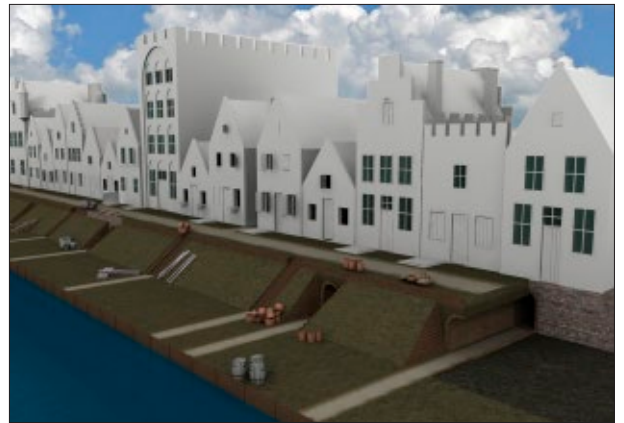
Afb. 2.1b Via een tunnel van kade naar huiskelder (1175-1200). Ergens aan het eind van de twaalfde eeuw werd een eerste tunnel gemaakt onder de straat door, zodat de handelswaar vanaf de werf of kade direct en gelijkvloers naar de huiskelder van het boven aan de straat gelegen grachtenpand kon worden verslept.
