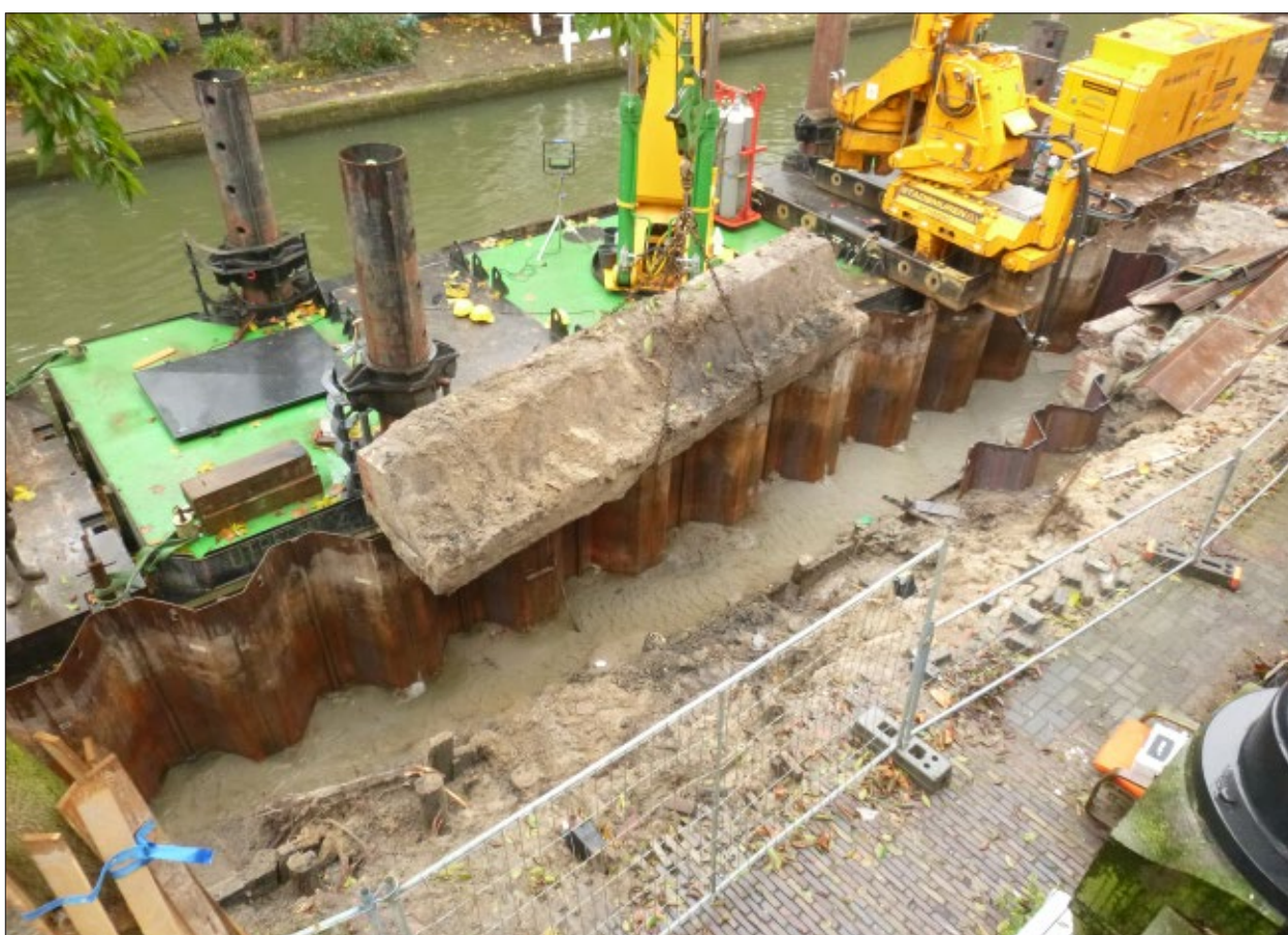
Afb. 3.4 Damwandmethode fasen 2 en 3: na het ontgraven wordt een stuk walmuur verwijderd. Rechts is de nieuwe damwand al naast het oude onderloopheidscherm gedrukt (rak 11 west).
