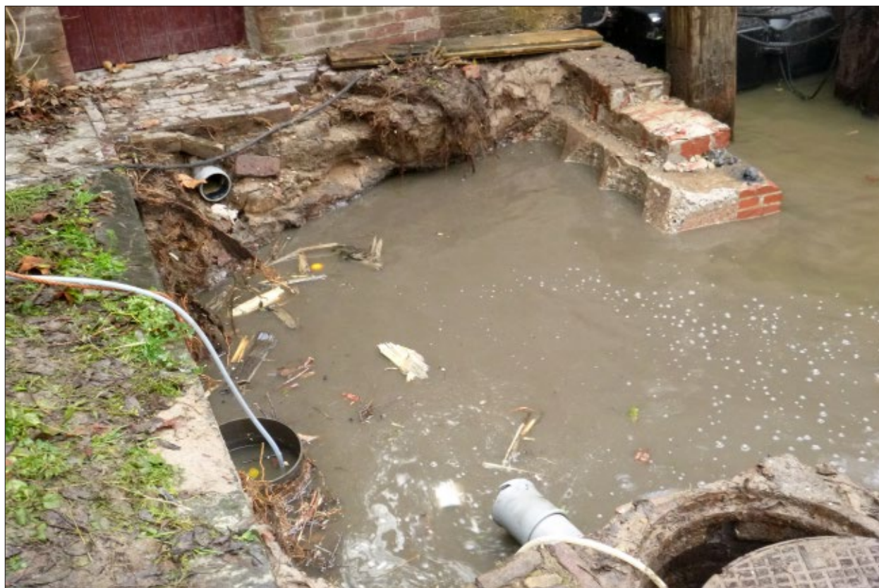
Afb. 4.14 Het gat dat gegraven was bij de Gaardbrug is direct volgelopen met water uit de gracht. Rechtsboven is de walmuur met boorgaten te zien.
