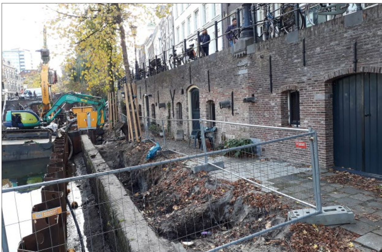
Afb. 3.3 Damwandmethode fase 2: met een graafmachine op een ponton wordt grond achter de walmuur ontgraven. Het water tussen de damwand en de walmuur is al naar een lager peil gepompt (rak 1 west).
