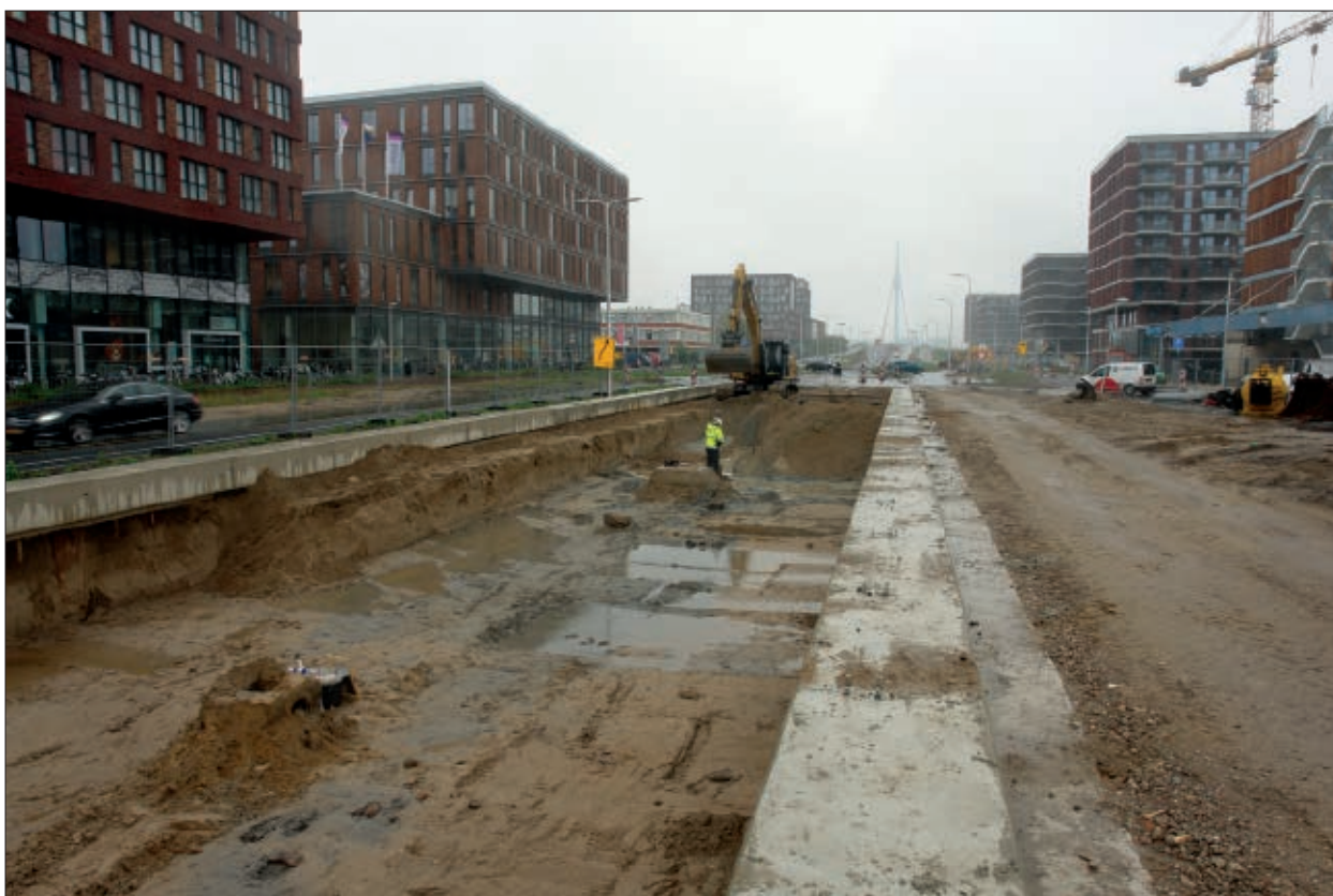
Afb. 4.2 De opgravingsput waarbij de kolkaten van de riolering uit het vlak steken, gezien richting het zuidwesten.
