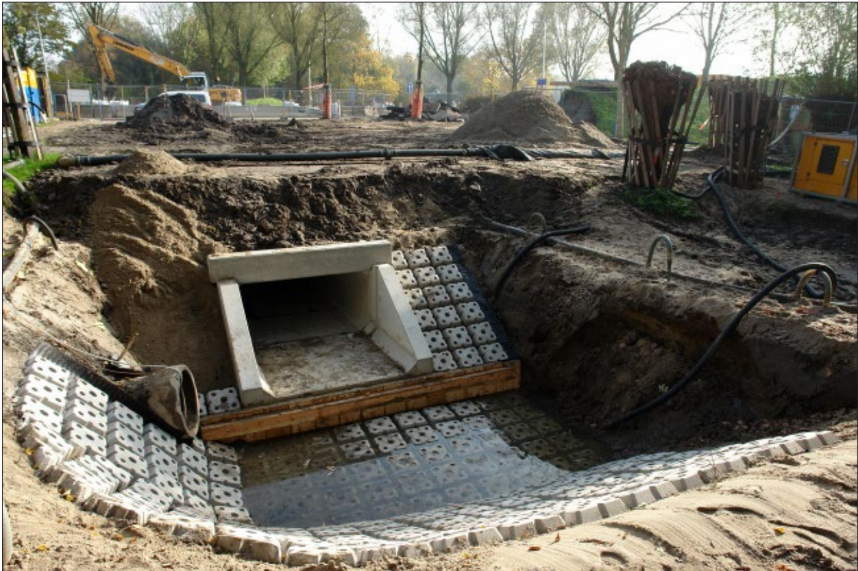
Afb. 5.2 Het westelijke uiteinde van de duiker (gezien in oostelijke richting). De tijdelijk gedempte sloot (rechts) moet nog worden open gegraven.
