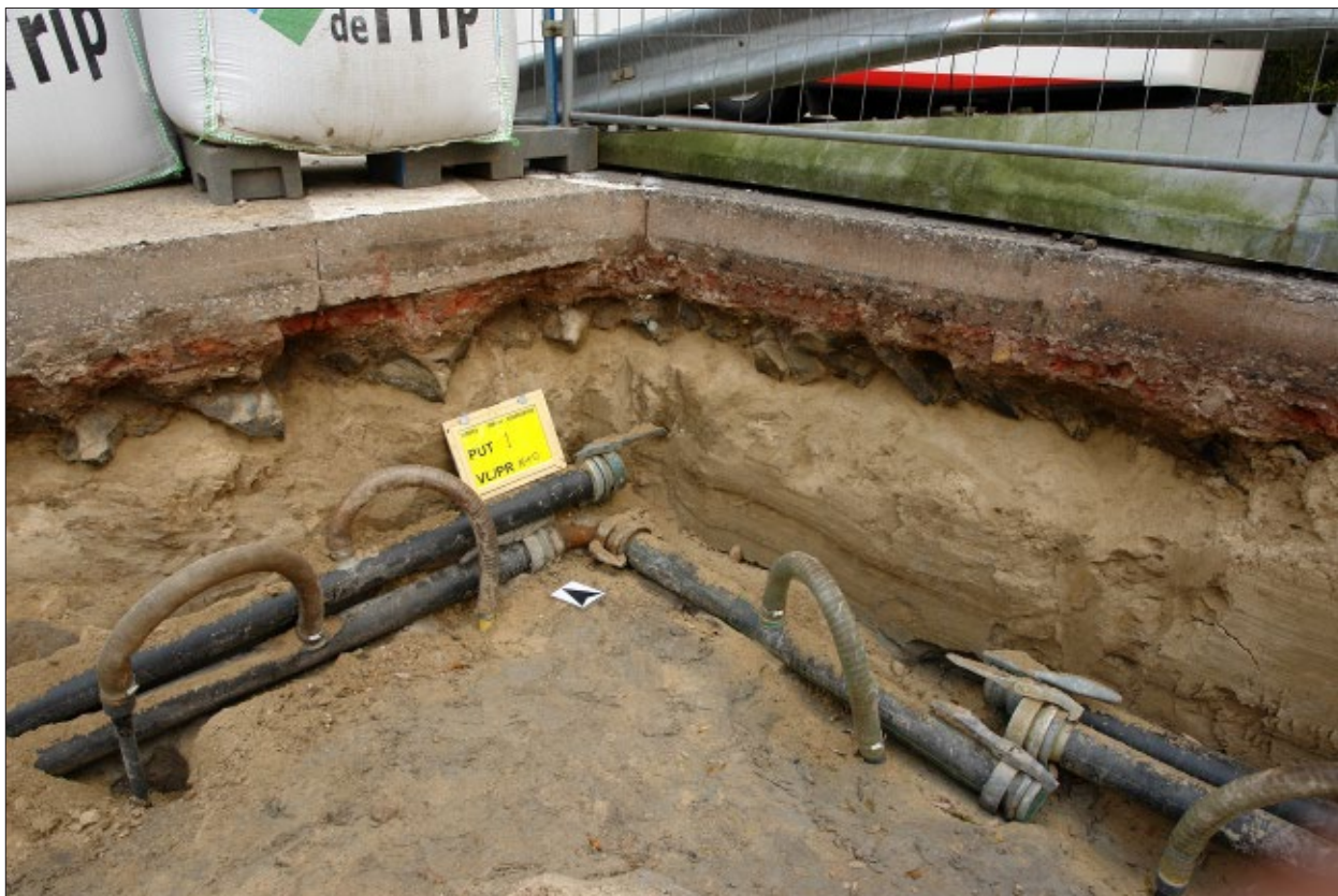
Afb. 7.1 Onder het asfalt van de Meerndijk werd een laag bakstenen (S2) aangetroffen, met daaronder een laag met grote fragmenten natuursteen (S3), gezien in noordwestelijke richting.
