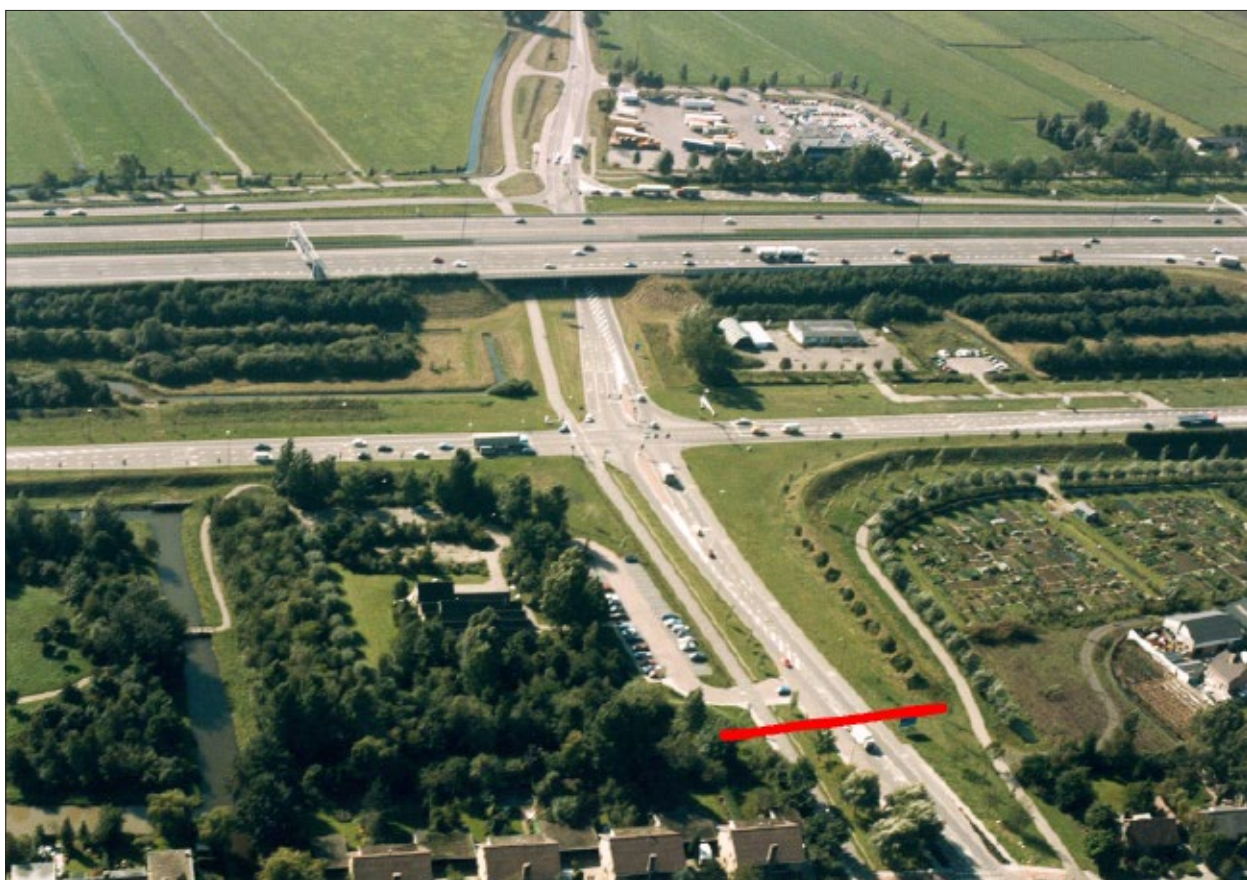
Afb. 1.2 Luchtfoto van de C.H. Letschertweg en de Rijksweg A12 (achtergrond) in De Meern uit september 1989 (noorden onderaan de foto). In het midden van de foto loopt de Meerndijk van noord naar zuid, in rood het huidige plangebied. (H.N. Bol, collectie Het Utrechts Archief, 88864.)
