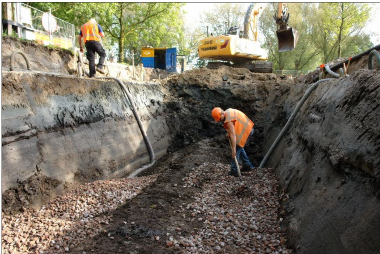
Afb. 5.1 Het westelijke deel van de sleuf tijdens het aanbrengen van de beide drainagebuizen aan weerszijden van de putbodem en het afdekken daarvan door middel van een laag gebroken puin. Dit puin diende als fundering voor de betonnen duikerelementen (gezien in oostelijke richting).
