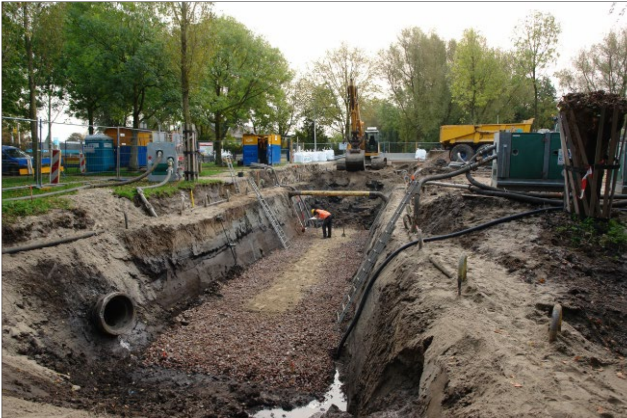
Afb. 1.3 Het westelijke deel van de sleuf na het aanbrengen van een laag gebroken puin als fundering van de duiker (gezien in oostelijke richting).
