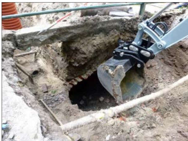
Afb. 4.15 De zuidelijke beerput (S1-S2) bij het verwijderen van een deel van de koepel. Hierna kon de holte opgevuld worden zodat de bodem weer stabiel was.
