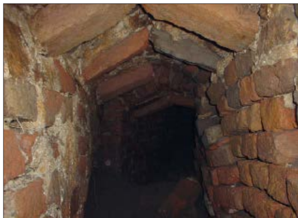
Afb. 4.5 Een foto genomen in riool R2, aangetroffen tijdens de opgraving in 2003. Op deze foto is te zien dat het riool op dezelfde manier is opgebouwd als de inlaat van beerput S1, met een keperboog aan de bovenzijde.
