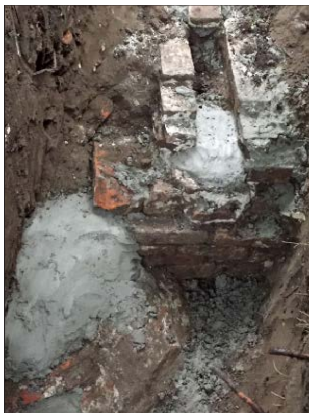
Afb. 4.16 De noordelijke beerput (S19) na het dicht metselen van de gaten.
