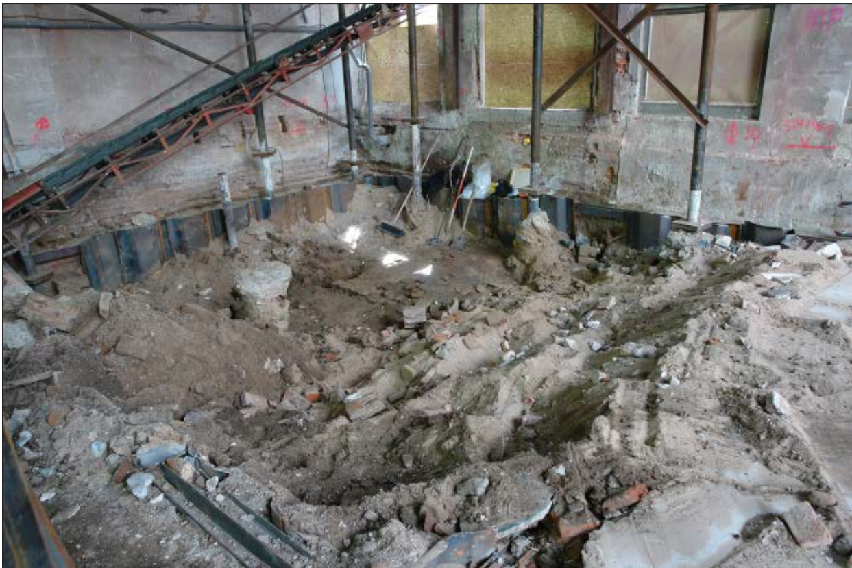
Afb. 3.1 De werkput in de beginfase van de ontgraving. Tegen de achterwand staat de transportband die de grond afvoert naar de straat (Masegast). De foto is genomen naar het zuidwesten.
