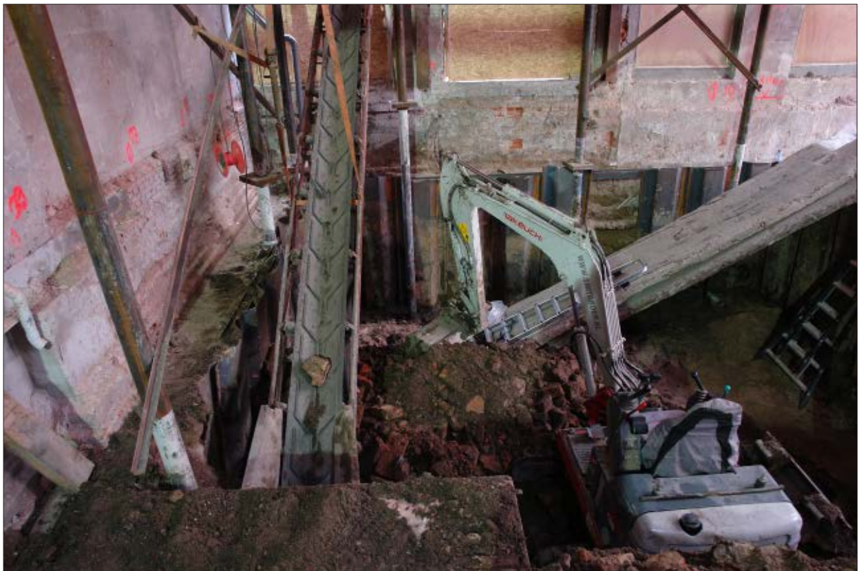
Afb. 3.2 De werkput in de eindfase van de ontgraving. Het laatste vlak wordt aangelegd en tegen de noordelijke damwand liggen al zware planken waarover de graafmachine weer naar boven moet rijden. De foto is genomen naar het westen.
