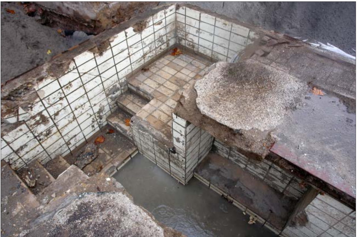
Afb. 5.11 De nog intacte binnenzijde van een van de drie smeerputten van een voormalig garagebedrijf op het perceel achter het woonpand Maliesingel 74.
