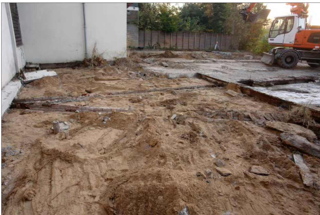
Afb. 4.1 Voordat de grond werd weggegraven werd eerst de verharding tot op het zand weggehaald. Met machinaal gegraven kijkgaten is vervolgens onderzoek gedaan naar eventueel nog aanwezige (moderne) funderingen. Dit om goede inschattingen van de benodigde werkzaamheden te kunnen maken en uiteindelijk puinresten goed te kunnen scheiden van de nog te verwijderen (vervulde) grond. Opname op het terrein achter woonpand 74, gezien richting het noorden.
