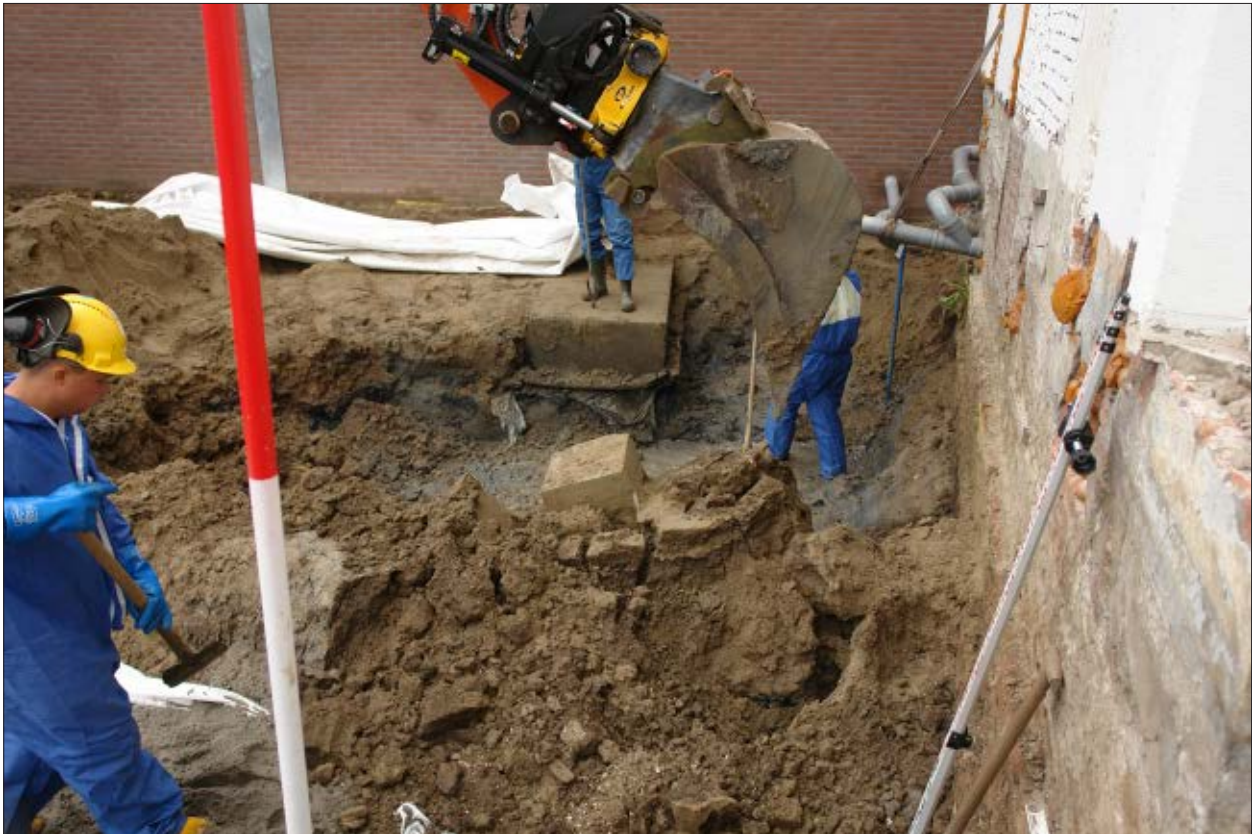
Afb. 5.4 Actiefoto bij het verwijderen van moderne betonnen funderingen en het saneren van met diesel vervuilde grond in een groot gedeelte van werkput direct achter de woonpanden Maliesingel 75 -76, gezien richting zuidwesten.
