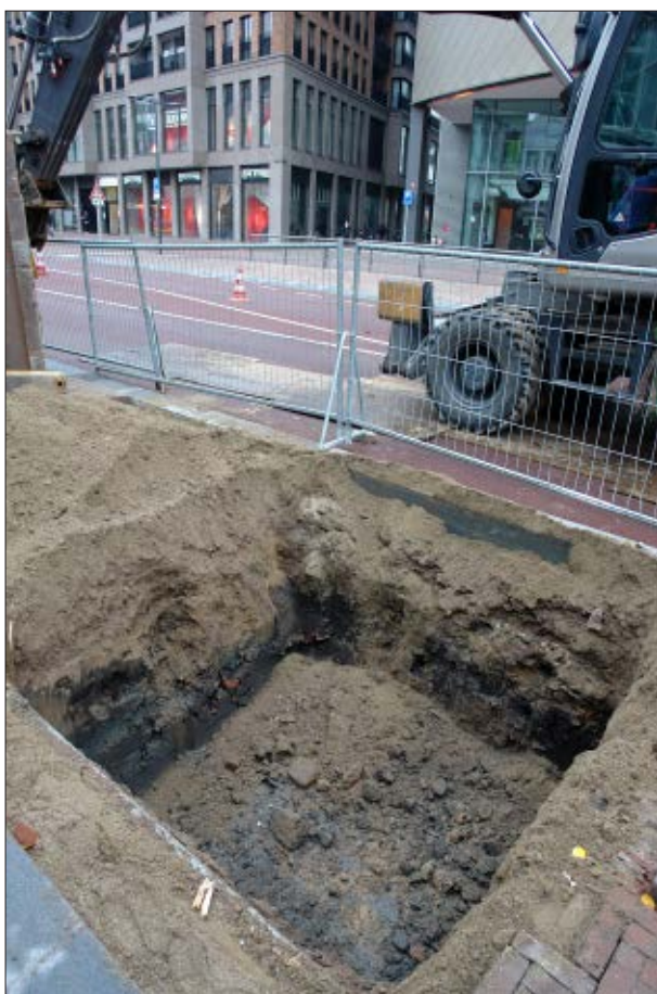
Afb. 3.1a De belangrijkste stadia tijdens het plaatsen van een ondergrondse afvalcontainer (ditmaal aan het Vredenburg): Als eerste wordt een gat van 1 tot 1,5 m diep gegraven.
