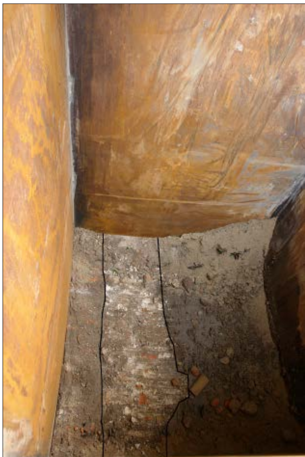
Afb. 4.2 Een puinlaag (S1 in put 1), die mogelijk diende als grondverbetering onder een fundering (gezien in oostelijke richting).
