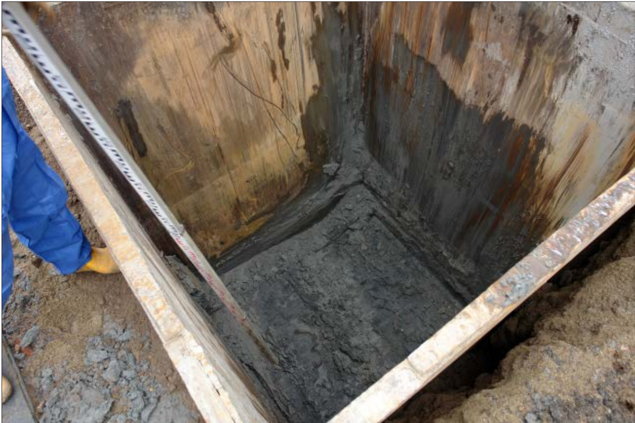
Afb. 3.1c Binnen deze bekisting wordt het gat dieper uit gegraven tot ongeveer 3 meter onder maaiveld.
