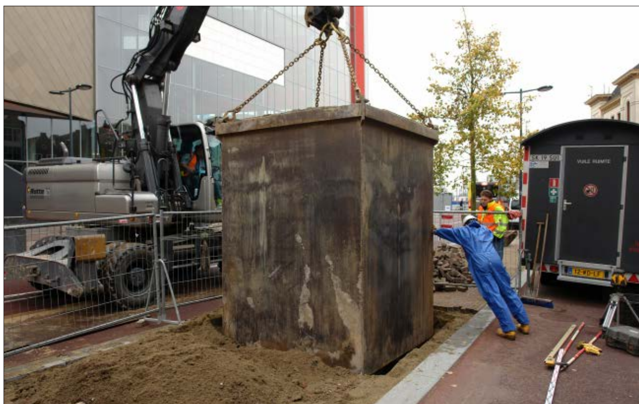
Afb. 3.1b. In het gat wordt vervolgens een stalen bekisting zonder bodem aangebracht.
