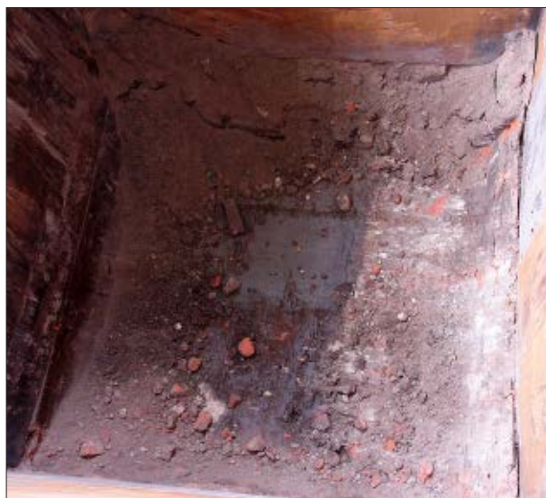
Afb. 4.5 Het pakket van mortel en kloostermopgruis (S4; rechts op het vlak) dat als grondverbetering onder de fundering S3 werd aangebracht, gezien in westelijke richting.
