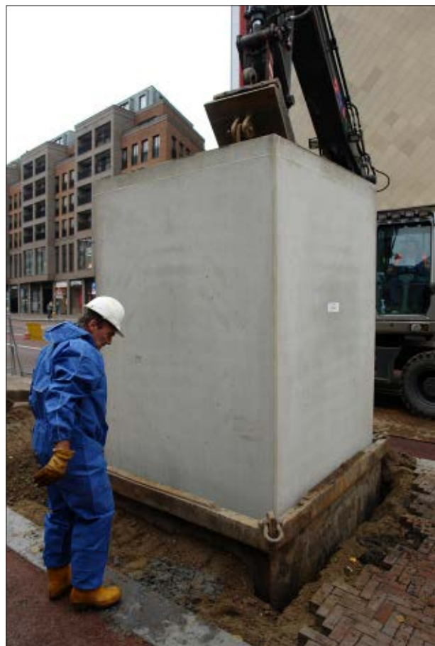
Afb. 3.1d De betonnen behuizing van de ondergrondse container wordt in de stalen bekisting geplaatst, die daarna verwijderd wordt.
