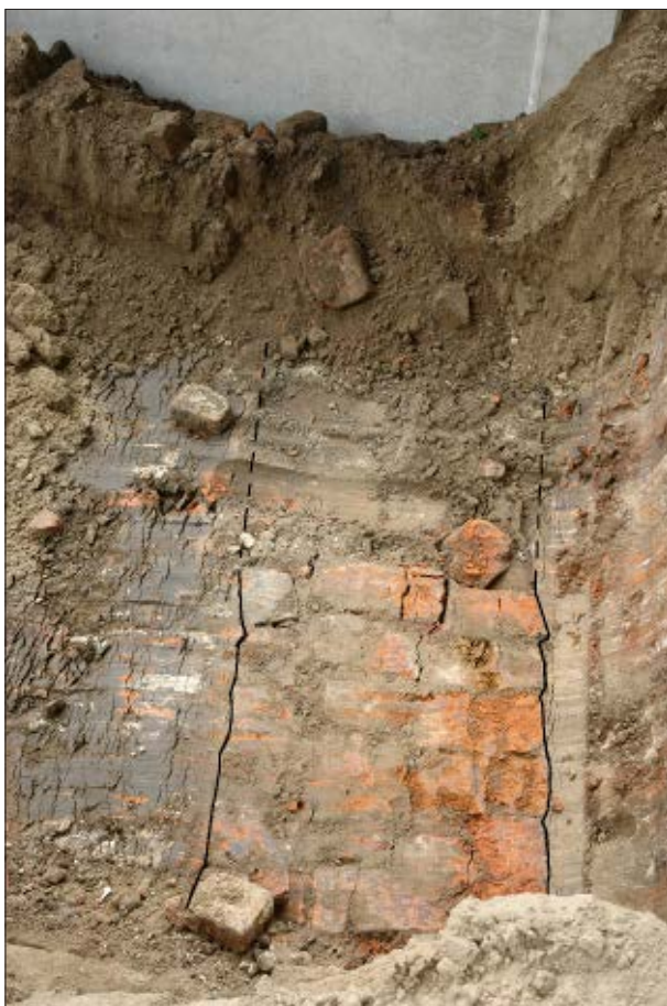
Afb. 4.4 De fundering S3 in put 2, gezien in westelijke richting.
