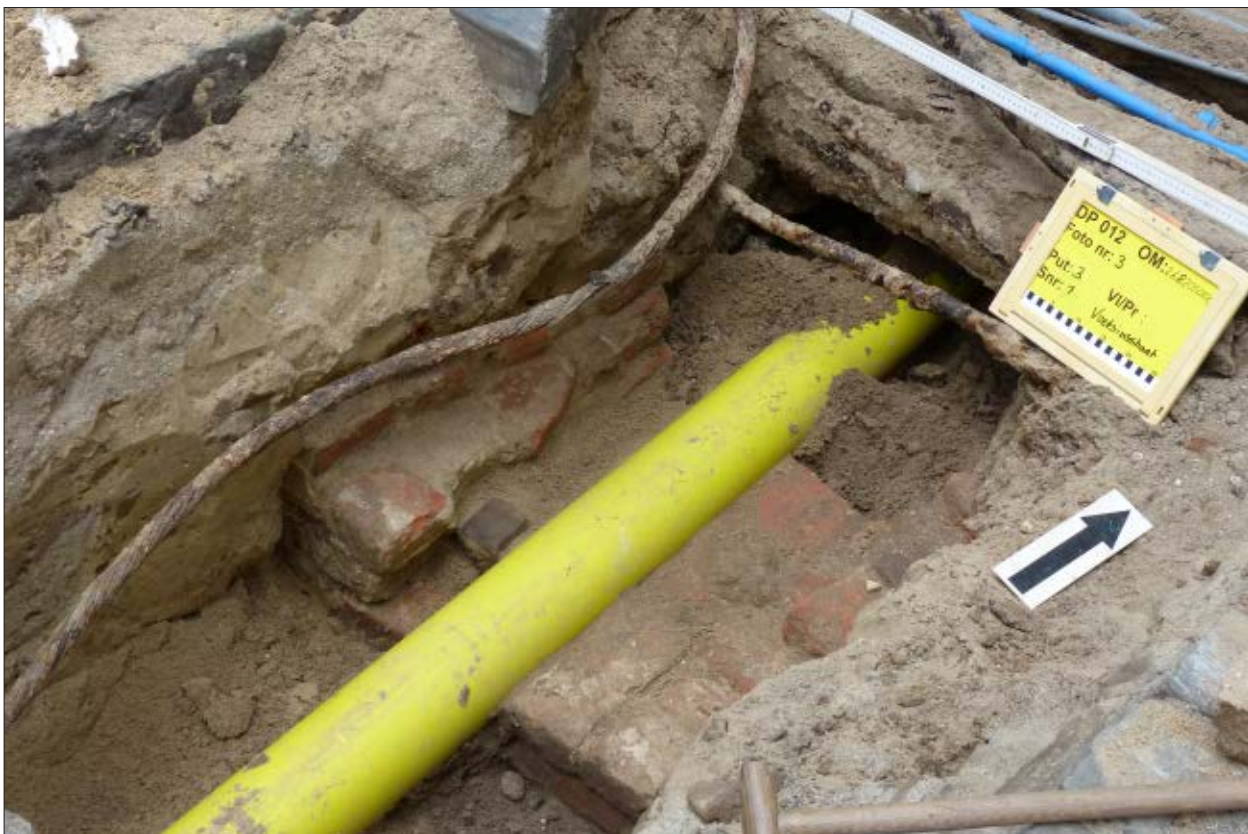
Afb. 2.4 De opgegraven fundering met de gasbuis in de Voetiusstraat.
