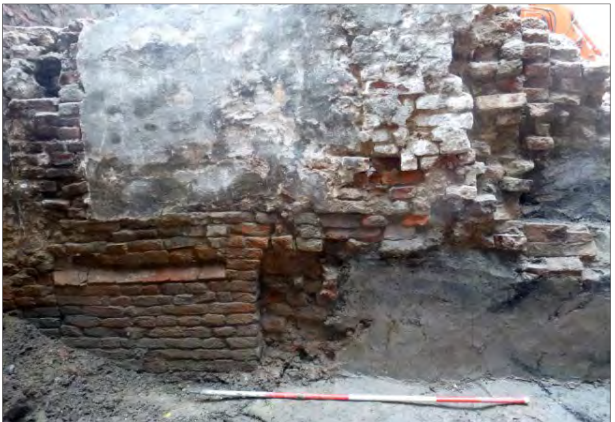
Afb. 5.6 Voorbeeld van intacte natuurlijke bodemopbouw in zuidwestelijke hoek van het plangebied met kleige restgeulafzettingen onder muurwerk (rechts).
