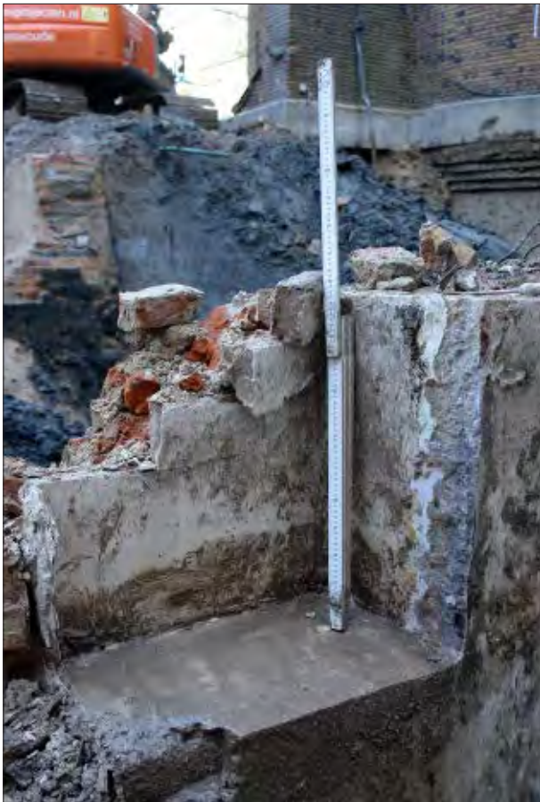
Afb. 6.42 De noordelijke nis tijdens de sloop van keldermuur KM09 (S102), gezien in noordwestelijke richting. De bodem en de wanden van de nis hebben een pleisterlaag, maar zonder de opvallende groene aankoeksels die in de zuidelijke nis werden waargenomen.
