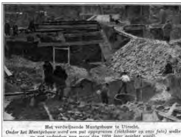
Afb. 2.4 Gezicht op het terrein van de Rijksmunt tijdens de afbraak in 1919 (gezien in zuidelijke richting). Onder een van de negentiende-eeuwse gebouwen van de Rijksmunt kwam de waterput van het Ceciliaklooster tevoorschijn. (Bron: Het Utrechts Archief, catalogusnr. 80573.)
