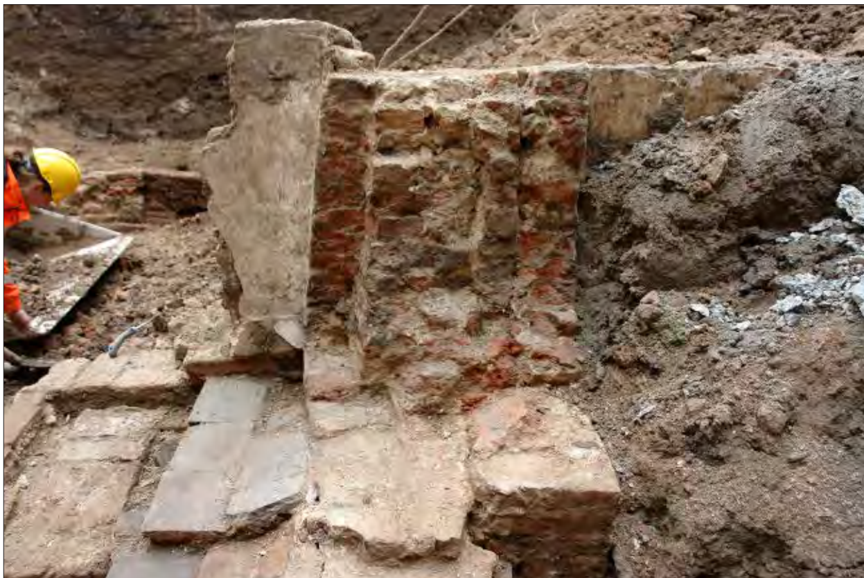
Afb. 6.43 De zuidmuur (S101) en klampmuur (S103) van de kelder van Gebouw 9, gezien in westelijke richting.
