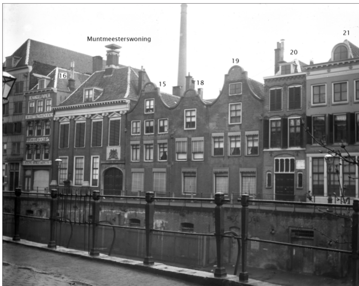
Afb. 2.18 De gevels van de gebouwen van de Rijksmunt langs de Oudegracht in de periode 1905-1915. (Bron: Het Utrechts Archief, catalogusnr. 810562.)
