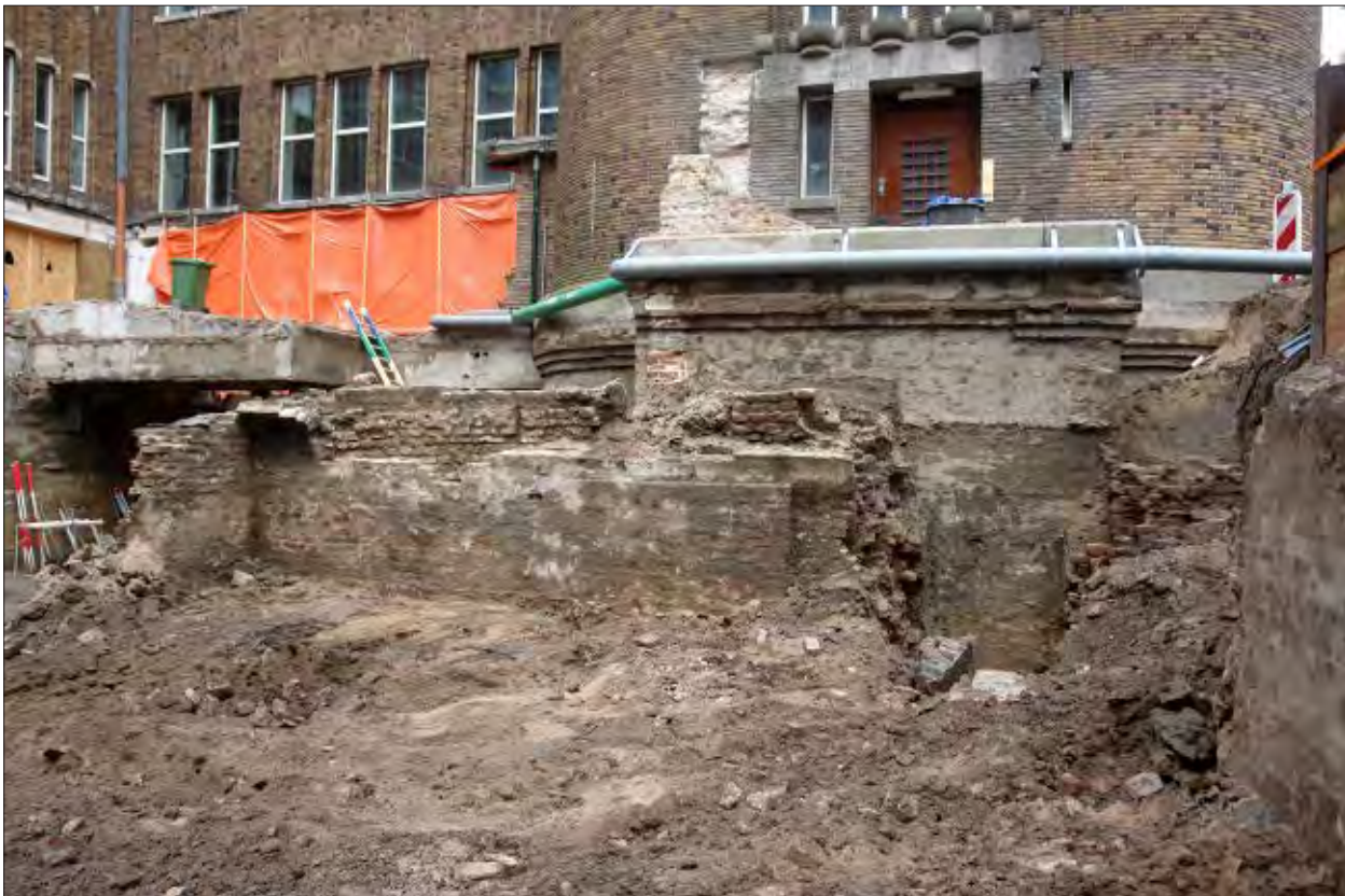
Afb. 6.34 De keldermuur KM01, gezien in zuidelijke richting. Het gat in de keldermuur rechts op de foto is ontstaan tijdens het couperen van KM01.
