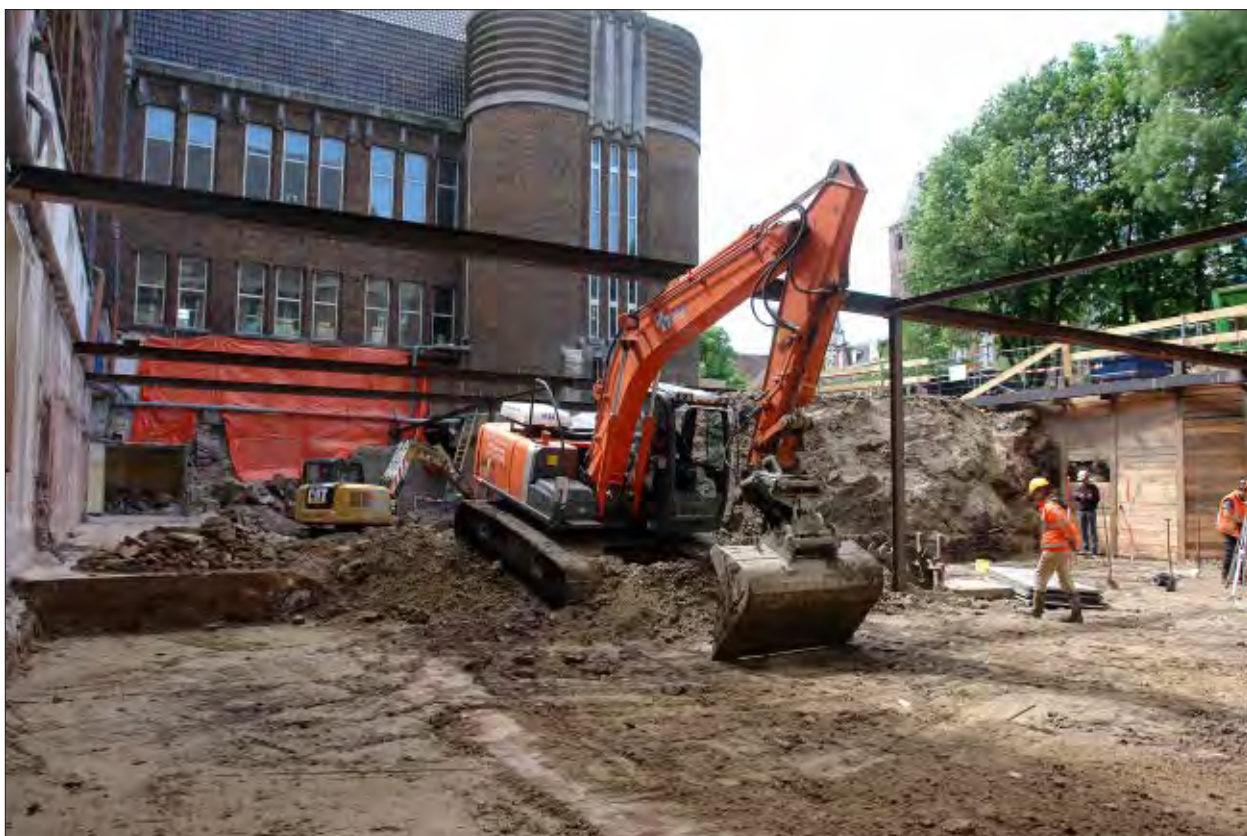
Afb. 4.4 Het opgravingsterrein op 17 mei 2018, gezien in zuidelijke richting. De aanwezige stutten bemoeilijkten het aanleggen van het laatste vlak en het uitgraven van de westzijde van het opgravingsterrein sterk.
