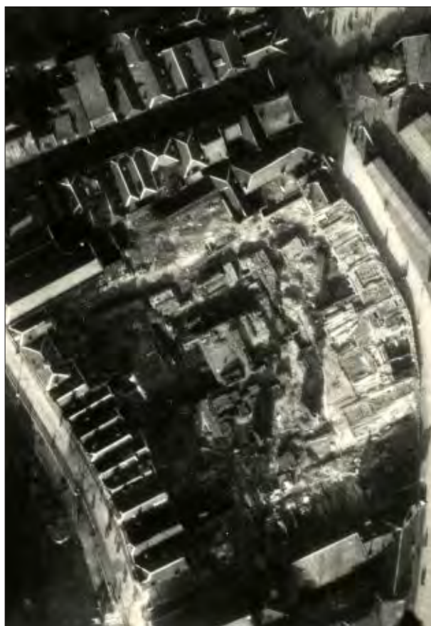
Afb. 2.20 Luchtfoto van de situatie op de Neude in (vermoedelijk) het begin van 1919 (bron: onbekend).
