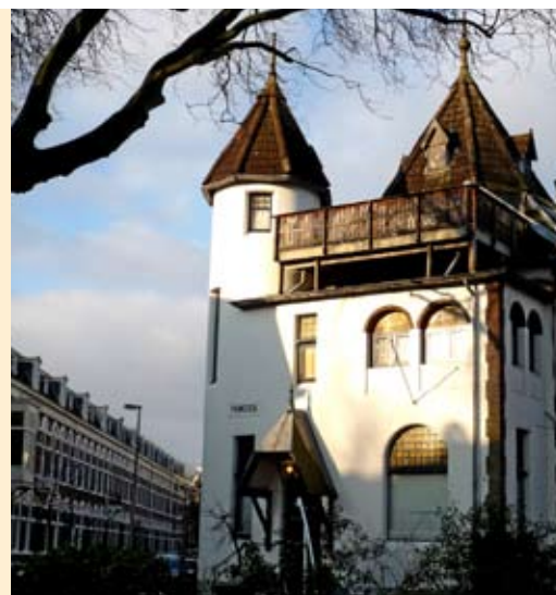
In de tegenwoordige Zeeheldenbuurt werd in 1905 een aantal prachtige witgepleisterde villa's neergezet. De grootste villa, als dokterswoning bedoeld, kwam op de kop te staan van de M.H. Trompstraat en is tegenwoordig beschermd als rijksmonument. De andere villa's zijn gemeentelijk monument.
