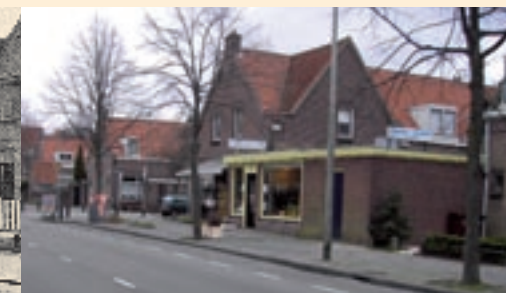
21 situatie vanuit punt 3 in 1917 en 2005. De tuilmuren zijn op veel plaatsen afgebroken of vervangen door bebouwing
