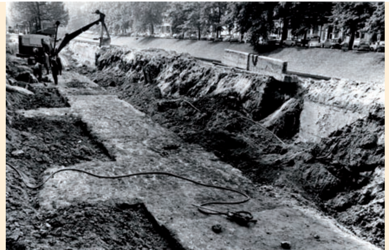
▲ De fundamenteën van de westelijke muur van Vredenburg tijdens werkzaamheden in 1968.
