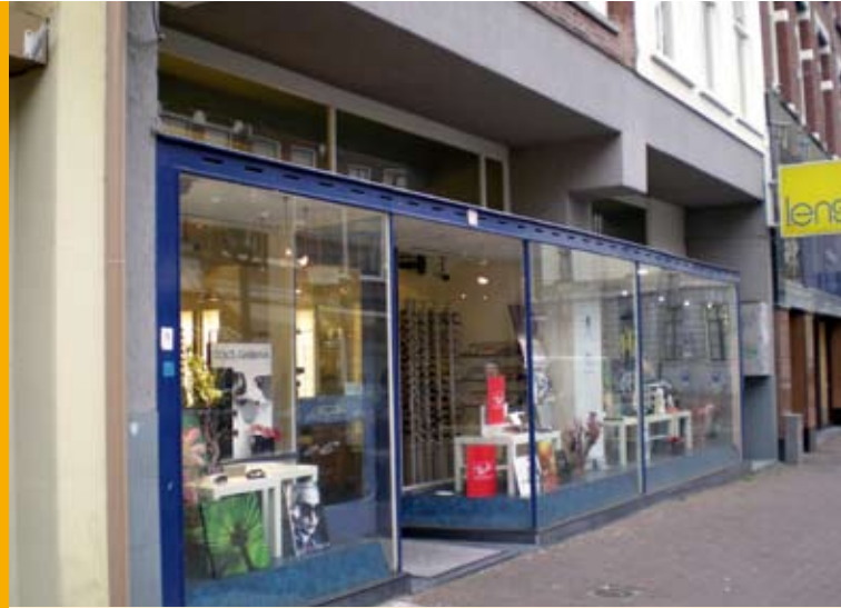
^ Oudkerkhof 15 (1924) is een van de functionalistische winkelpuien die Gerrit Rietveld in Utrecht heeft ontworpen. Door veel glas en dunne metalen strips te gebruiken, is de scheiding tussen binnen en buiten bijna onzichtbaar geworden. Het zicht op de etalage is hierdoor optimaal.
